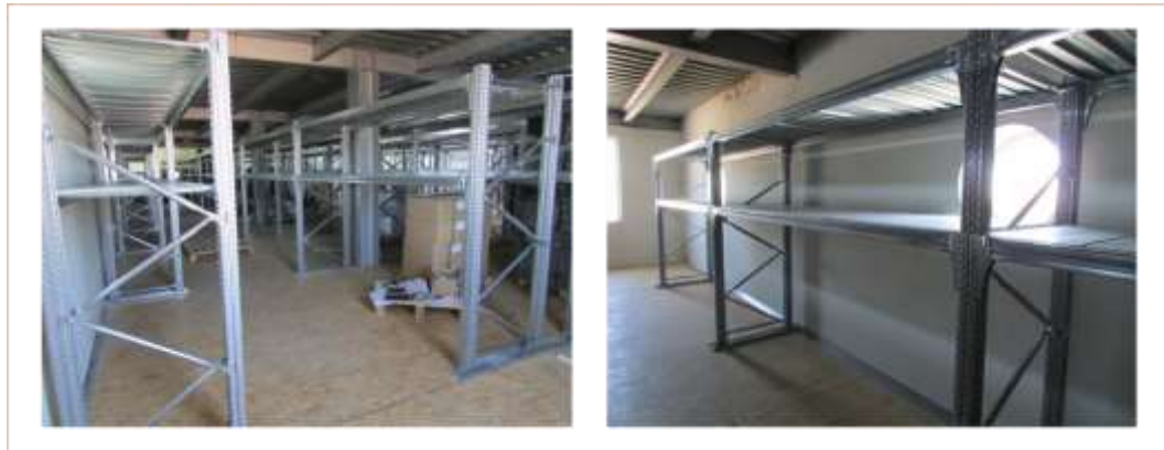
Figura 42 – Racks no novo armazém
