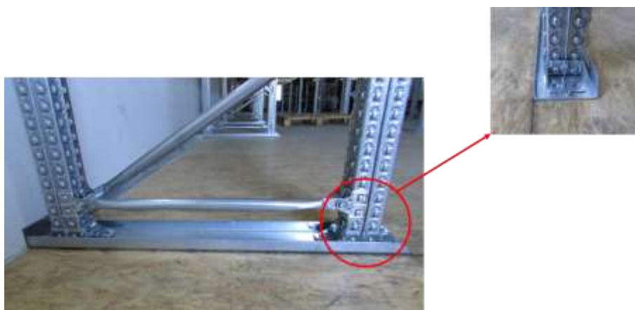
Figura 43 – Chapas aplicadas nos apoios dos racks
