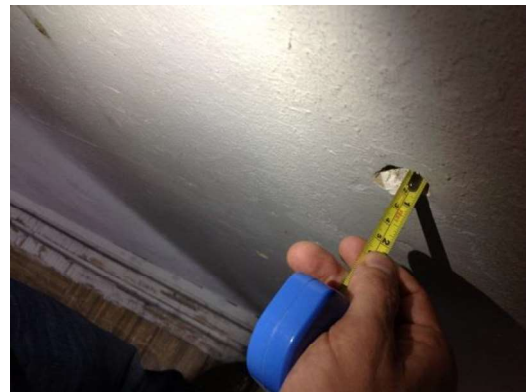
Figura 18: (Medição Paredes interiores)
