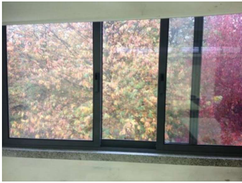
Figura 25: (Envidraçados Bloco C)
