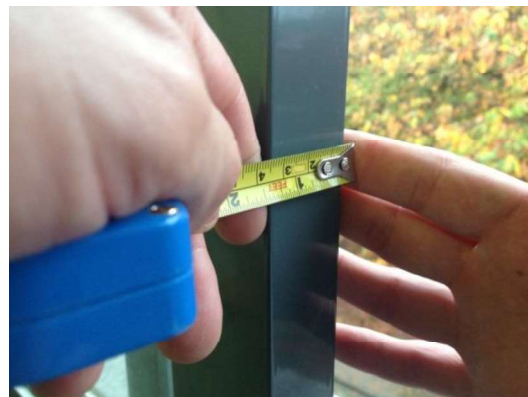
Figura 24: (Medição da Caixilharia Bloco C)
