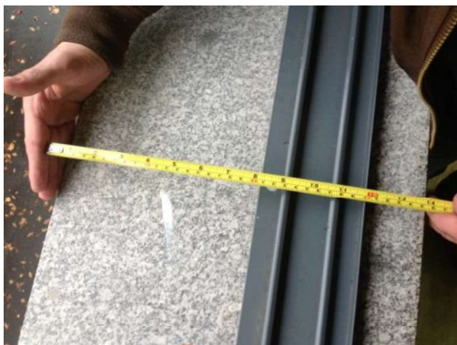
Figura 23: (Medição Parede exterior Bloco C)
