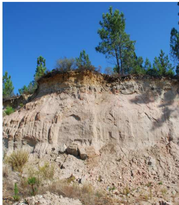
Figura 59: Catraia do Poços – Talude de uma escavação.
