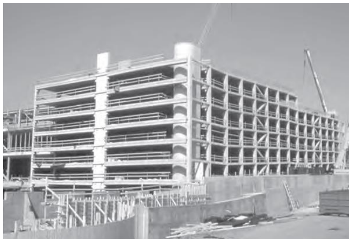
Figura 2.1 - Esqueleto de betão pré-fabricado, parque de estacionamento Green Apple. [27]
