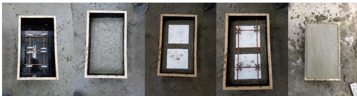
Figura 2.17 – Painél com poliestireno expandido. [32]
