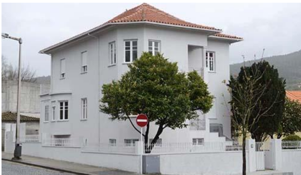
Figura 8– Edifício do CCD
