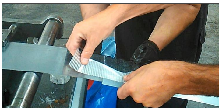
Figura 46: Colocação da fita para a união das chapas
