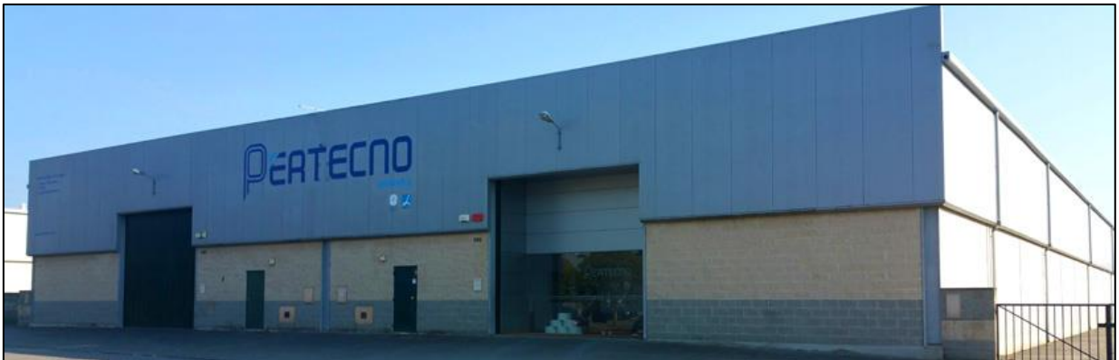
Figura 2: Instalações atuais da Pertecno em Ovar
