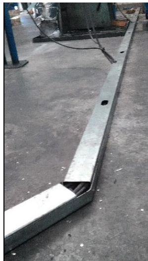
Figura 59: Depois de arrumação dos cabos elétricos
