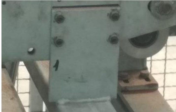
Figura 61 - Chapas de ligação dos tubos às estruturas
