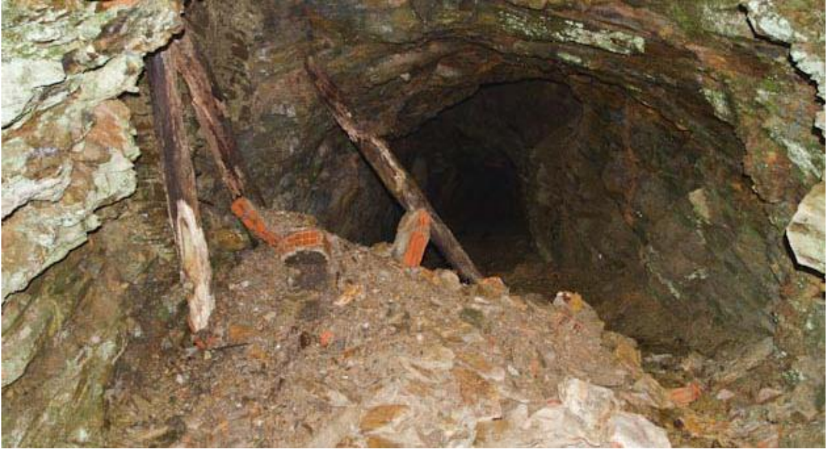
Figura 23 – Repérage realizada em 13 de Janeiro de 2010 às minas de Portelo mostrando desabamento no início da mina. (fotografia: António Morais)
