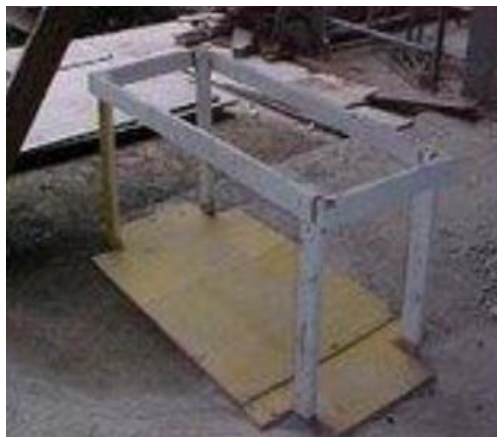
Figura 4-1 – Abertura de piso protegida (Medeiros [no date])
