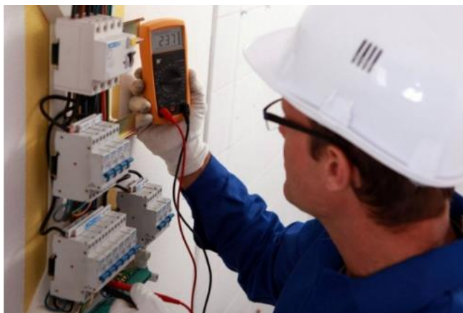
Figura 2-21 – Manutenção da instalação elétrica (Engenharia [no date])
