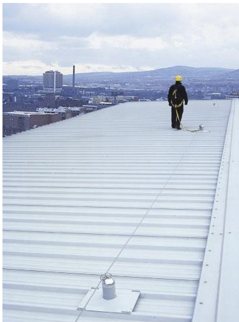
Figura 2-19 – Trabalho em cobertura (Brasil [no date])
