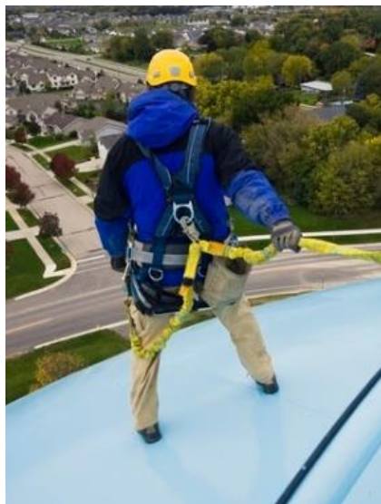
Figura 4-5 – Trabalhador com cinto tipo pára-quedista (Tuiuti 2015)
