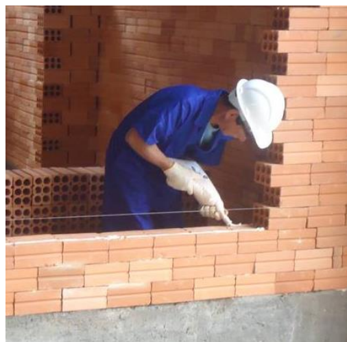
Figura 2-18 – Execução alvenaria (Habitissimo [no date])
