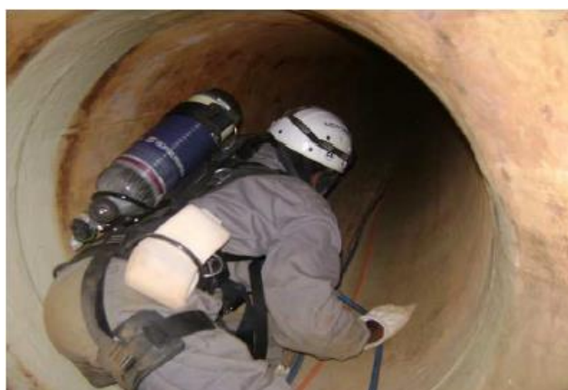
Figura 2-20 – Local confinado (Reis, Freitas 2013)
