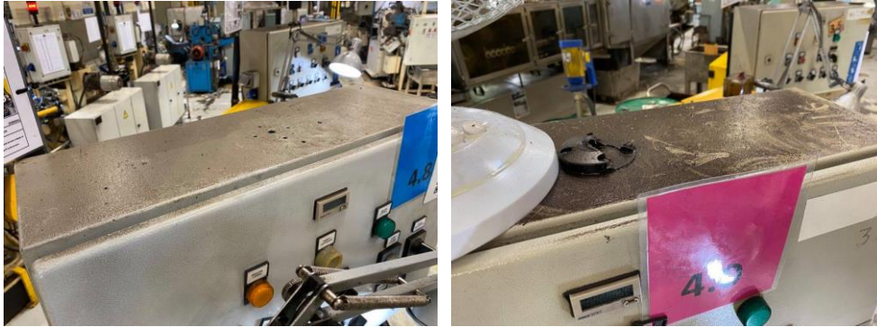
Figura 53 - Máquinas sem dispositivo de sinalização luminosa na Picagem
