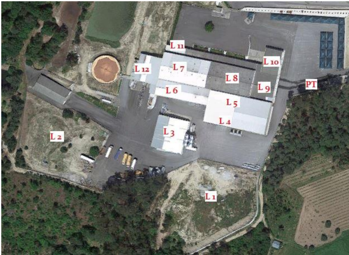
Figura 26: Imagem aérea identificação de locais potenciais a instalar a central fotovoltaica
