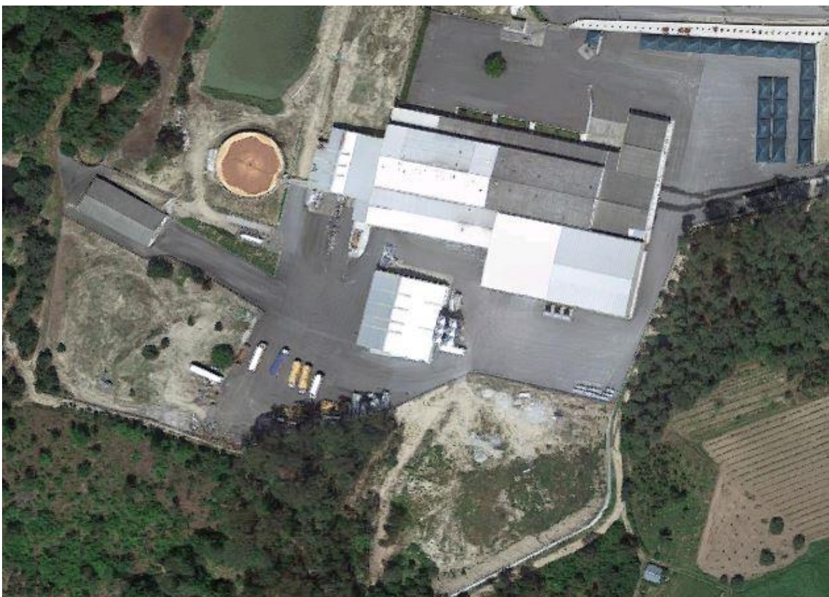
Figura 25: Vista aérea da Unidade Industrial
