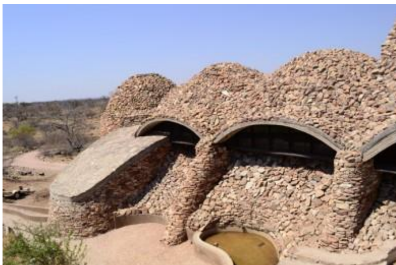
Figura 2.11 – Edifício na África do Sul com palas de sombreamento e aberturas para ventilação [Fonte: thesouthafrican]
