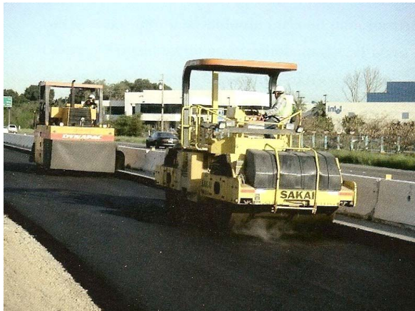
Figura 9 – Execução da camada de revestimento (Jalali, 2009)
