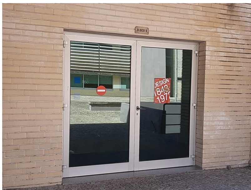
Figura 11 – Porta secundária do bloco D (normalmente disponível)
