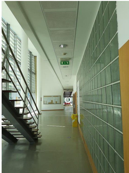
Figura 12 – Sinalética do corredor principal a indicar o sentido da porta de emergência
