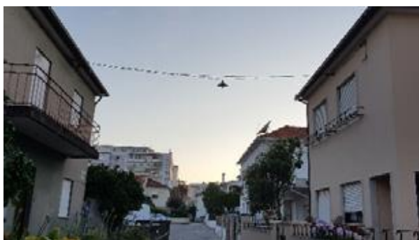
Figura 12: Cabo em suspensão [12]
