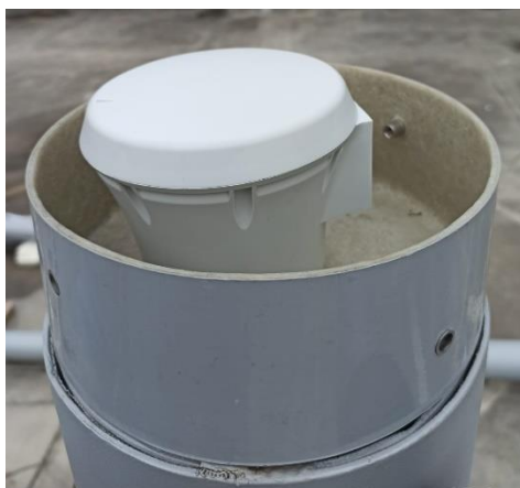
Figura 52: Antena Sencity Urban 100 instalada no topo da coluna de Iluminação Multisserviços
