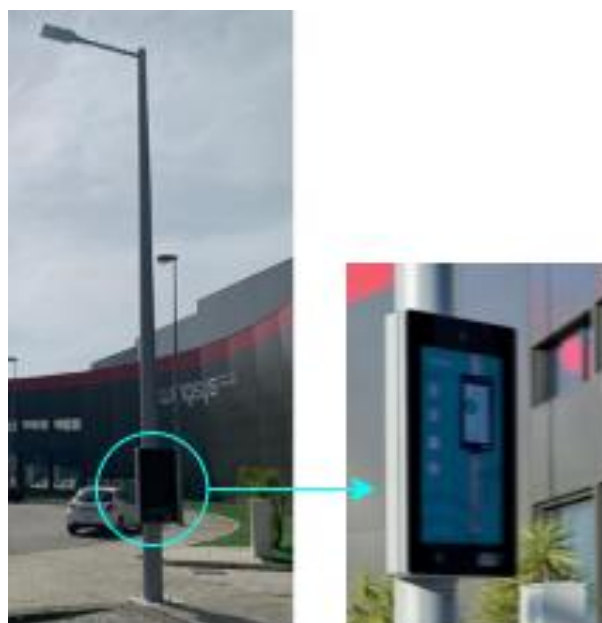
Figura 59: Exemplo de ecrã interativo inserido numa coluna de Iluminação Multisserviços em V.N. Famalicão
