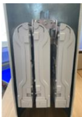
Figura 64: Integração de 3 PDOs no interior da coluna de Iluminação Multisserviços
