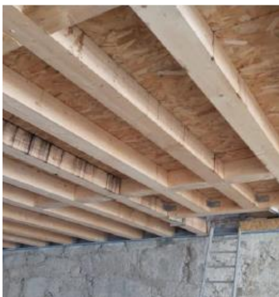
Figura 21 Pavimento realizado em vigas de madeira
