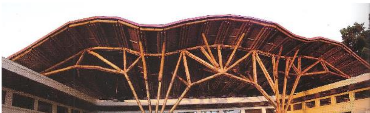
Figura 23 Cobertura realizada em bambu (Soares, 2013)
