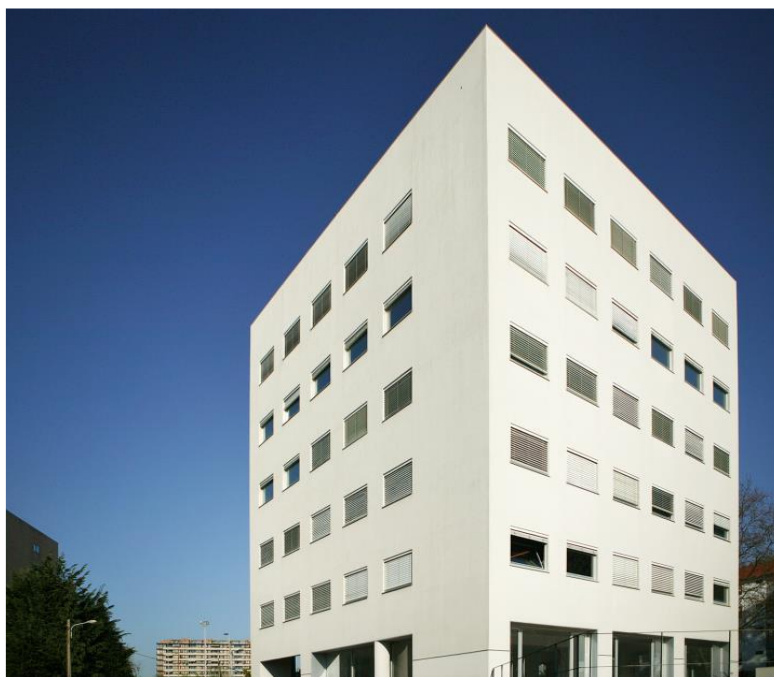
Figura 2 Edifício sede da Omega (Omega, 2023)
