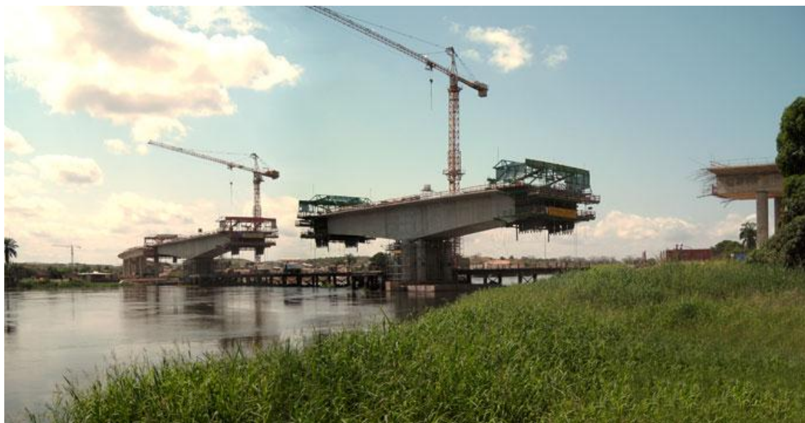
Figura 2.8-Construção da ponte 17 de Setembro, por avanços sucessivos [23]
