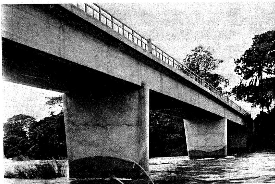
Figura 2.5- Ponte Pinheiro Chagas [5]
