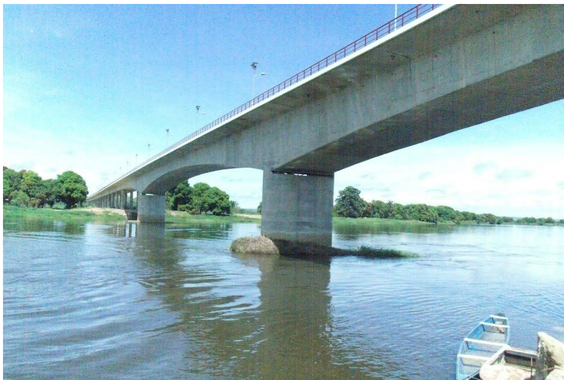
Figura 2.7- Ponte 17 de Setembro [24]
