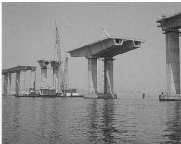
Figura 2.2- Vigas em caixão pré-fabricado, ponte Vasco da Gama [3]
