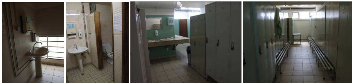
Quadro 6 - Balneários e sanitários.
