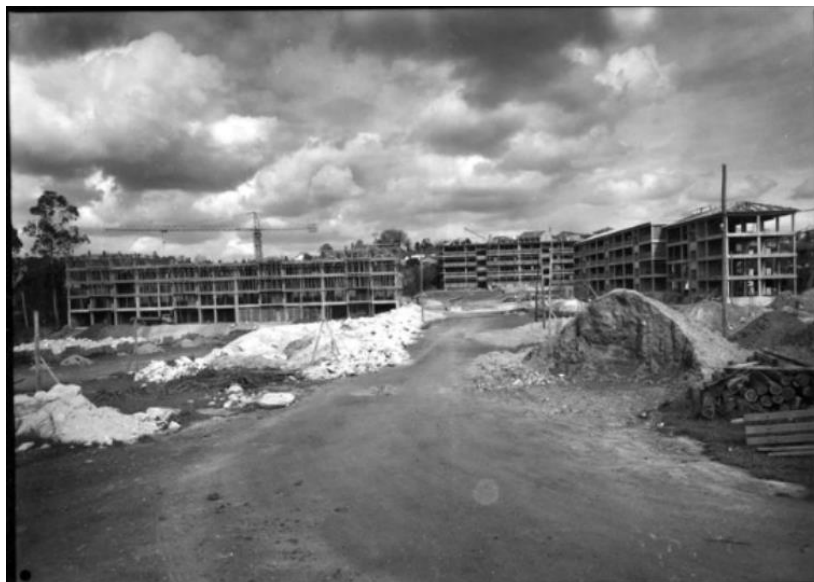
Figura 11 - Construção dos primeiros blocos do Bairro do Lagarteiro, 1970 (Fonte: https://gisaweb.cm-porto.pt/units-of-description/documents/649390/?q=bairro+do+lagarteiro )
