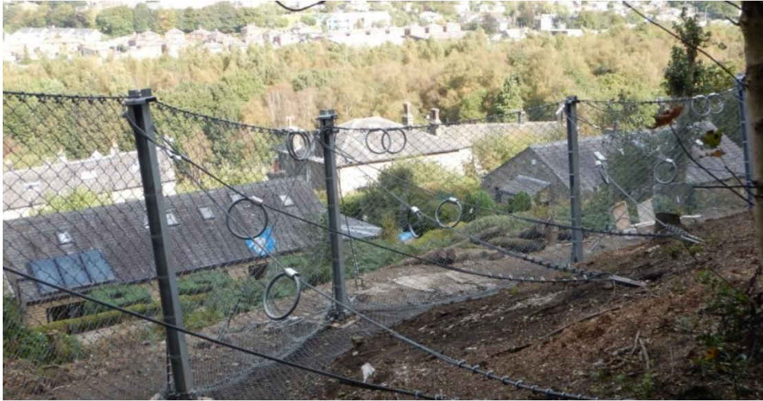
Figura 3.30 - Barreira flexível do tipo SL-150 da marca Geobruigg ( www.geobruigg.com ).
