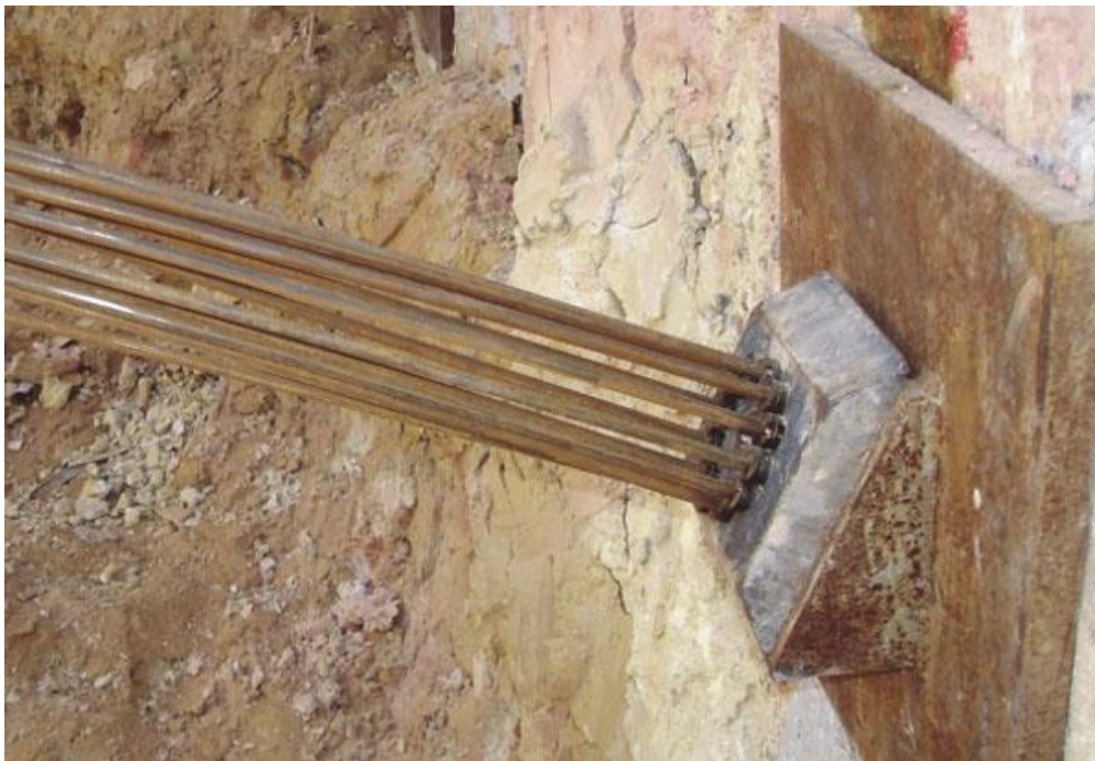
Figura 3.27 - Desenho esquemático de uma solução de ancoragem em terreno (www.scielo.mec.pt).
