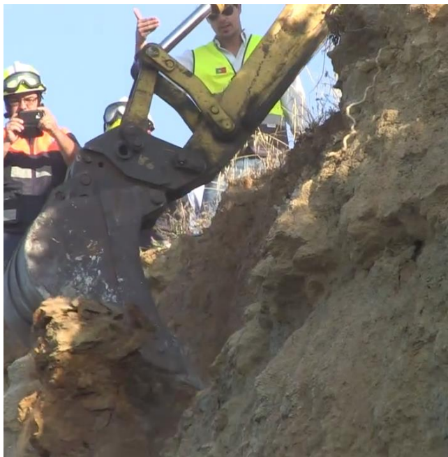
Figura 3.25 – Saneamento de arriba pela proteção civil ( www.cascais.pt ).
