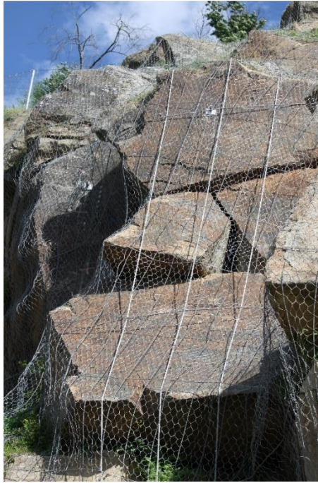
Figura 3.26 - Aplicação de rede de malha de arame.
