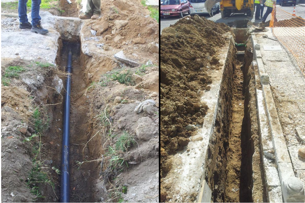
FIGURA 28 - ABERTURA DE VALA NOS LOTES 22 E 23
