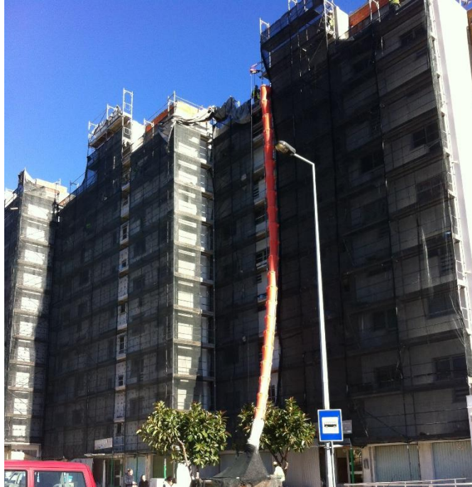
FIGURA 16 –ANDAIME COLOCADO NO BLOCO 11
