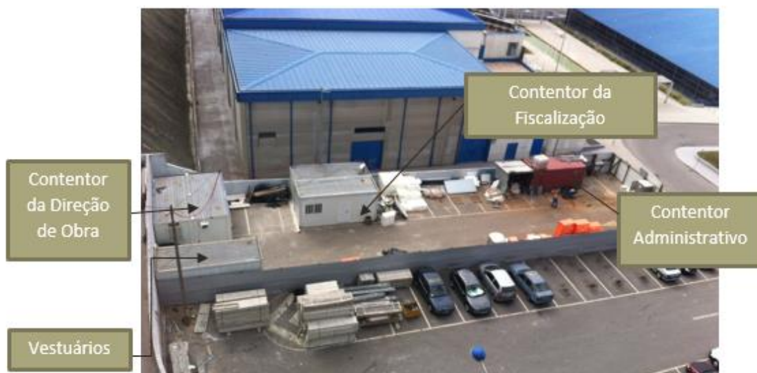
FIGURA 14 - ESTALEIRO PRINCIPAL DE OBRA
