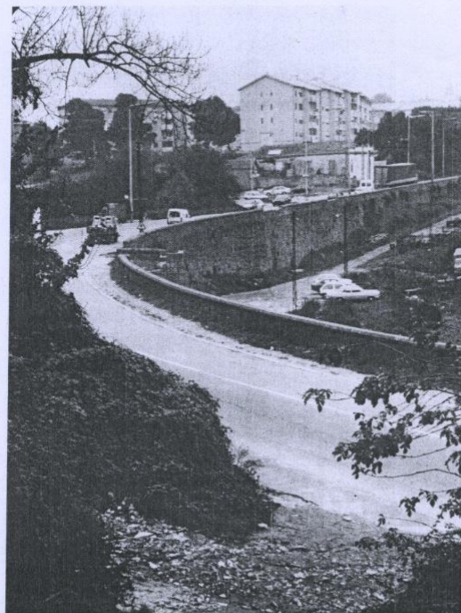
ESTRADA DA CIRCUNVALAÇÃO JUNTO A CAMPANHÃ. TRAMO DE UMA SÓ VIA, SUPORTADA POR UM MURO
