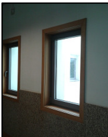
Figura 20 – Exemplo de um vão envidraçado presente no edifício.
