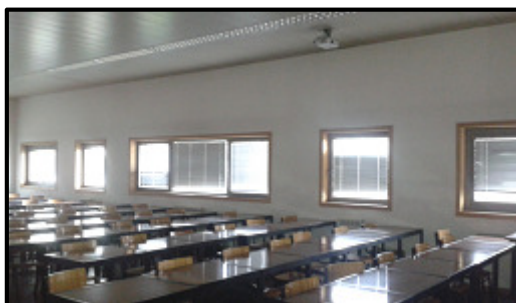
Figura 22 – Exemplo de um vão envidraçado presente no edifício.
