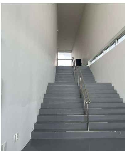
Figura 11- Escadas para acesso à bancada fixa
