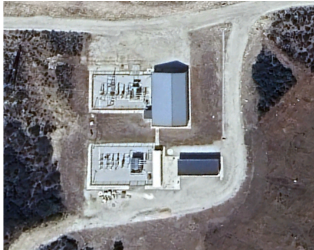
Figura 4.1: Localização da subestação do Subarque Eólico de Ser-nancelhe
