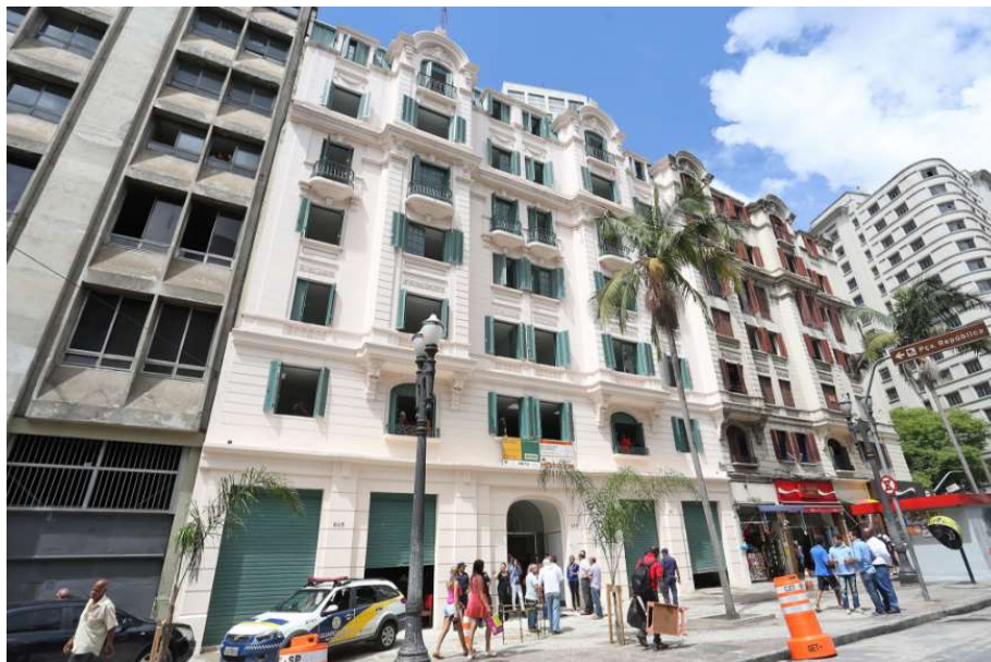
Fotografia 4.6 – Edifício Cineasta no período posterior a renovação.
