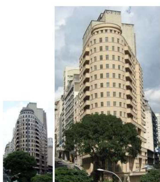
Fotografia 4.4 – Antes e depois da renovação do edifício Riachuelo.
