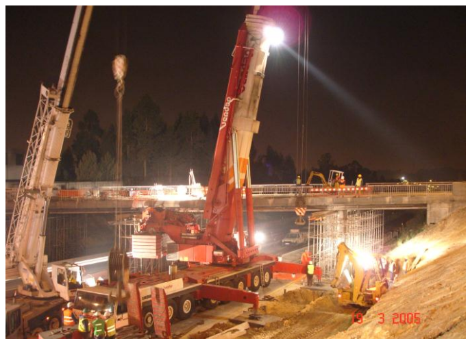
Ilustração 11 – Demolição de Passagem superior com recurso a cordão diamantado
