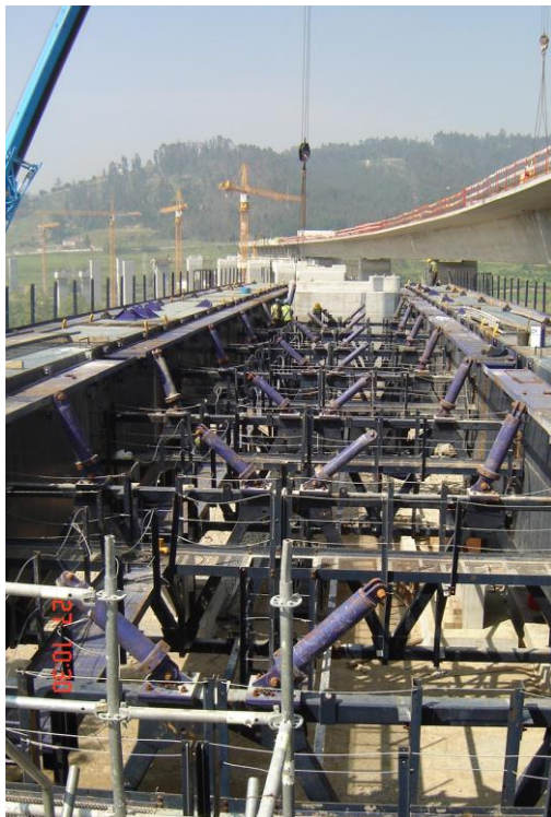
Ilustração 9 – Cimbra aérea auto lançavel inferior Viaduto Mezio – Lote 7
