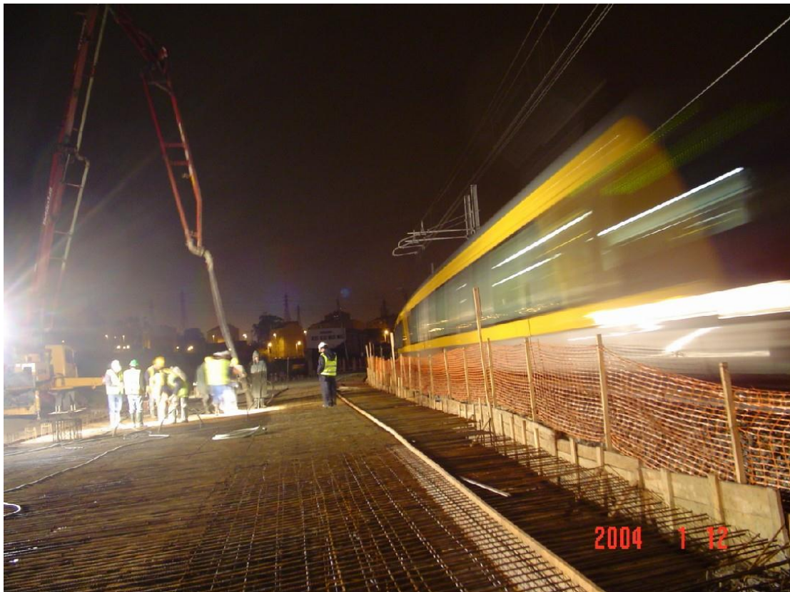
Ilustração 8 – Concessão Grande Porto – Construção da PI8CF – IP4 Nó de Sendim – Nó da Via Norte – Lote 1
