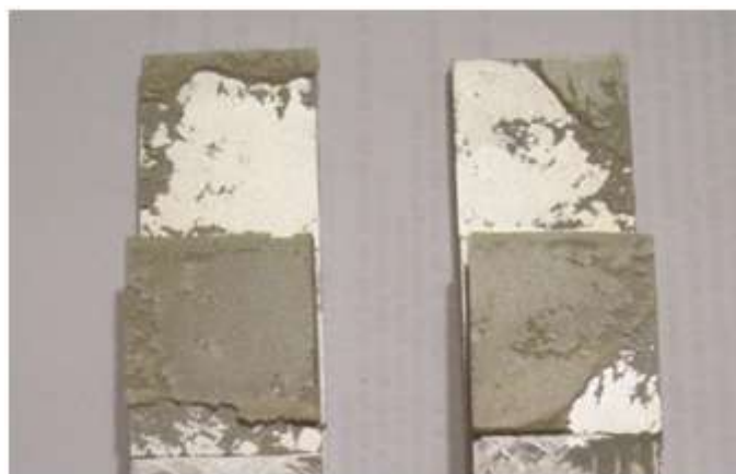
Figura 48 - Juntas reforçadas C3-1 e C5-1
