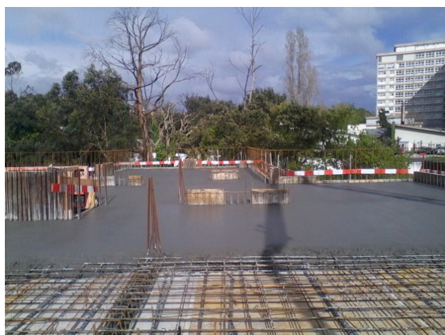
Figura 3.41 - Laje de cobertura
