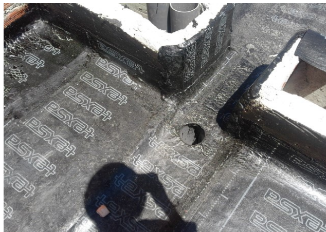
Figura 3.77 - Boca de descarga
