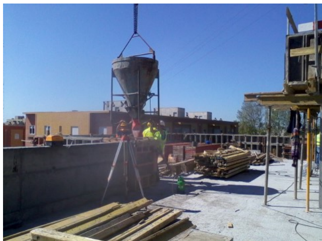
Figura 3.48 - Platibanda da cobertura
