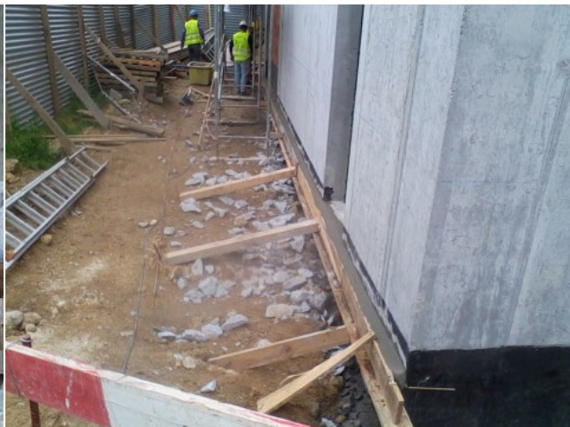
Figura 3.58 – Amassamento do “dente em betão”
