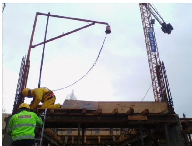
Figura 3.87 - Utilização de EPI
