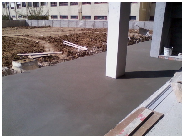
Figura 3.11 - Regularização do terraço da entrada a poente
