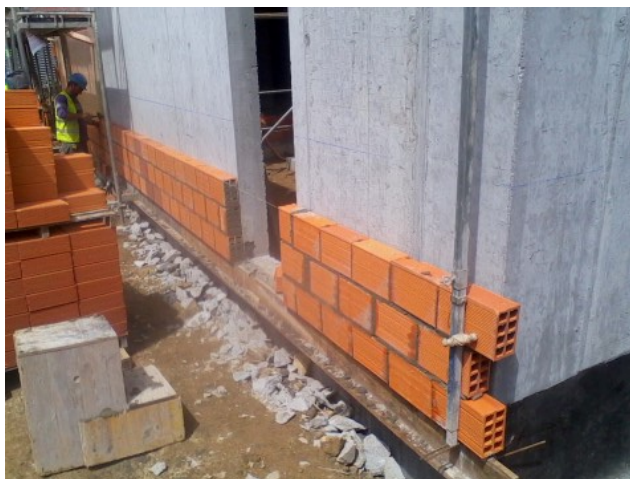
Figura 3.60 - Execução do pano exterior da fachada
