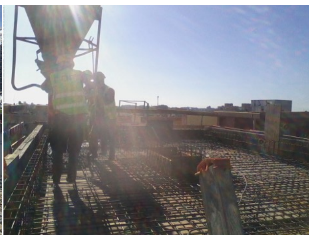
Figura 3.42 - Laje cobertura do núcleo
