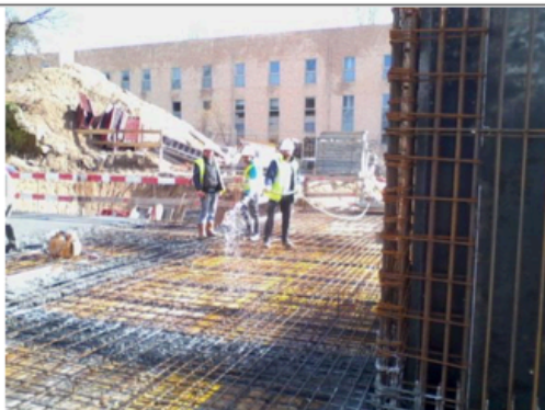
Figura 5 – Limpeza da cofragem
