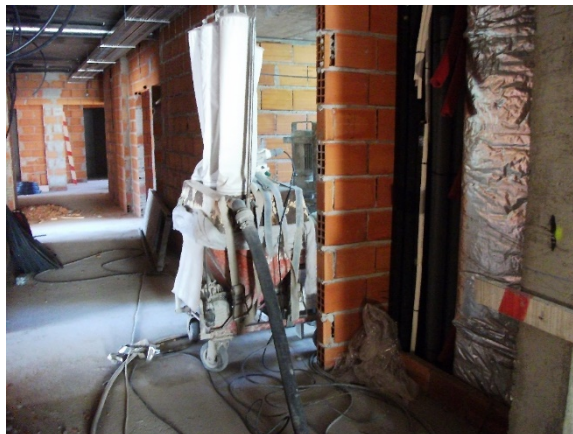
Figura 3.4 – Corredor do piso 2
