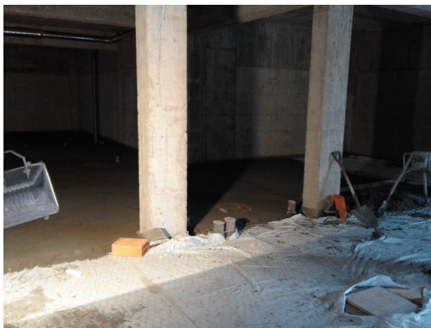
Figura 3.66 - Colocação de betonilha
