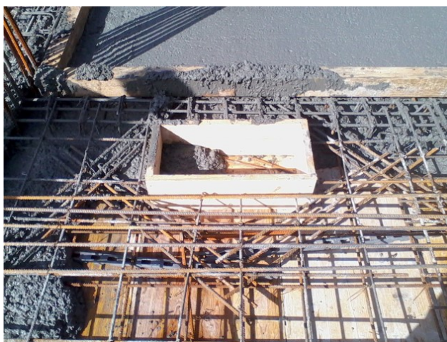
Figura 3.36 - Varões de reforço a colocar nas extremidades dos negativos
