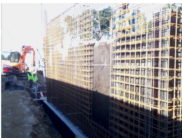
Figura 3.32 – Armação de muros de suporte
