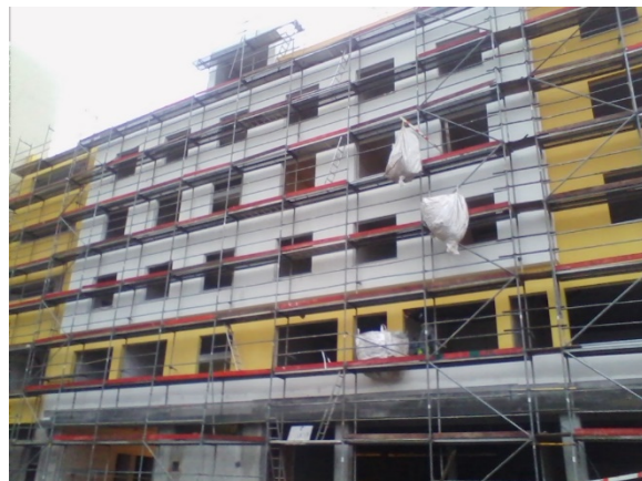
Figura 3.8 - Pintura das fachadas
