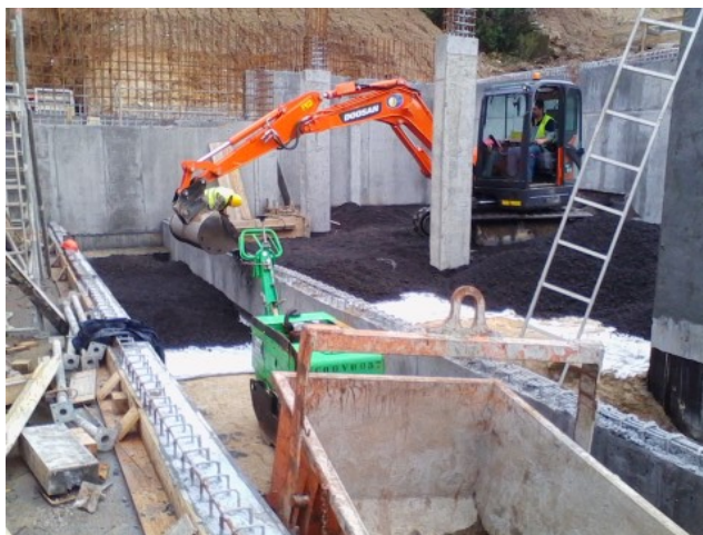
Figura 3.31 - Execução de aterro e aplicação de materiais de base para o pavimento térreo
