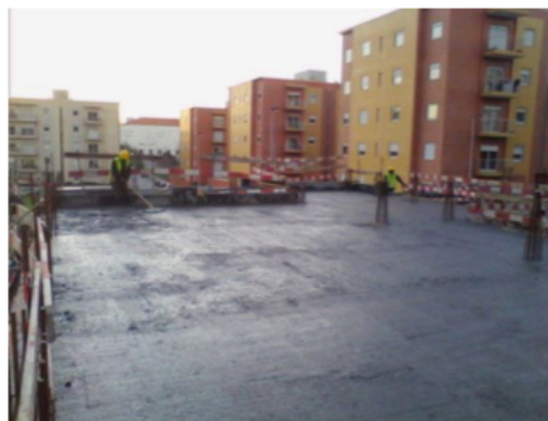
Figura 8 – Finalização da regularização do pavimento
