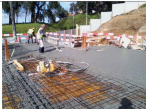
Figura 6 – Nivelamento do pavimento
