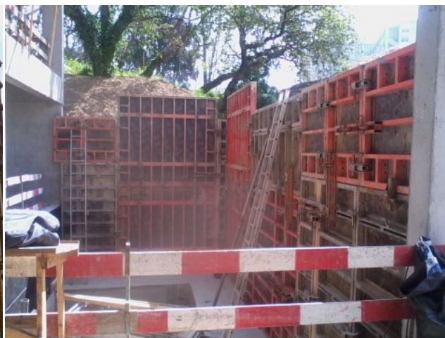
Figura 3.40 - Paredes de muros
