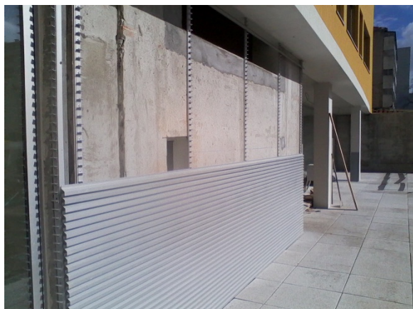
Figura 3.19 - Colocação de grelha de ventilação em ferros no alçado poente
