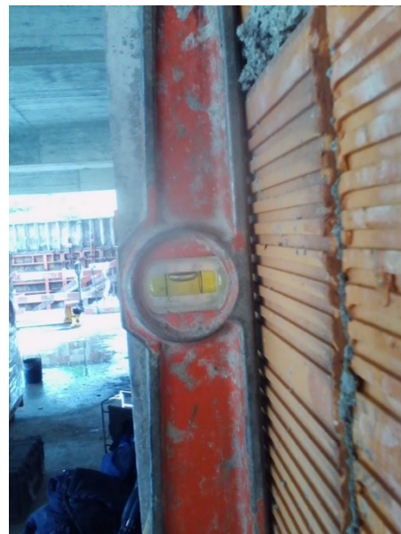
Figura 3.54 - Nivelamento das paredes
