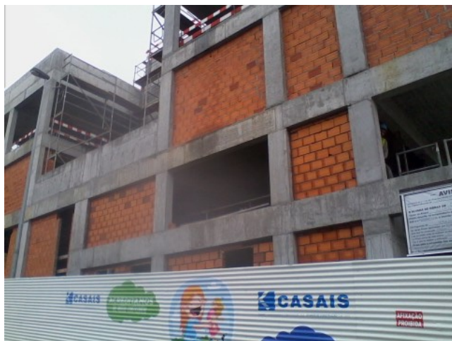
Figura 3.51 - Trabalhos de alvenaria
