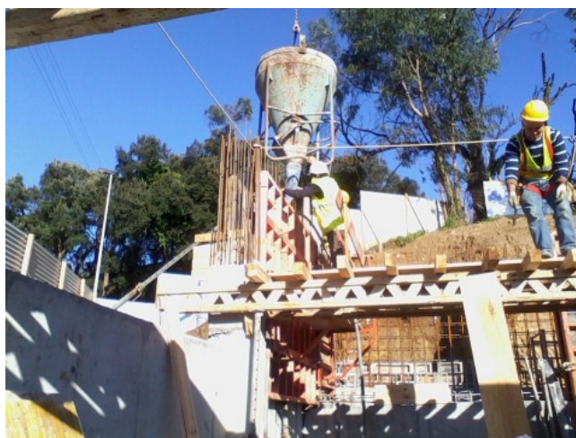
Figura 3.88 - Plataformas de trabalho
