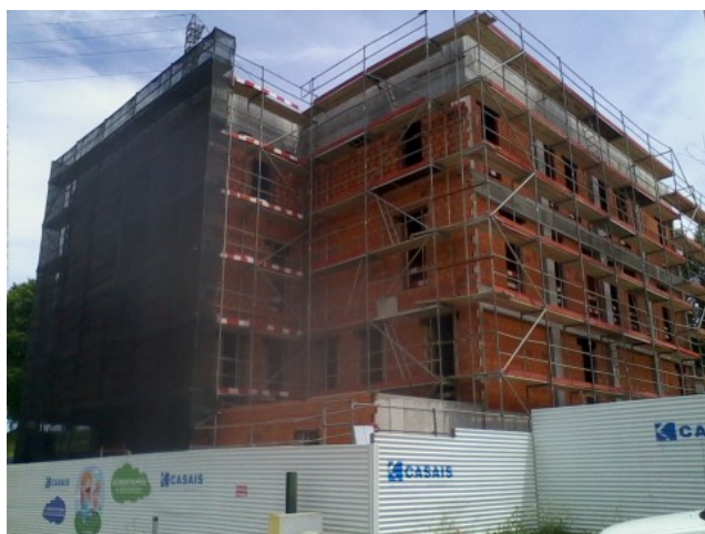
Figura 3.59 - Pano exterior da fachada
