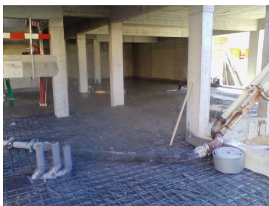
Figura 3.47 - Laje do piso 0
