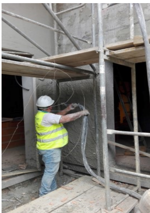
Figura 3.83 - Projeção de reboco exterior
