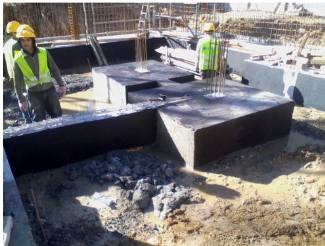
Figura 3.37 - Aplicação de pintura betuminosa
