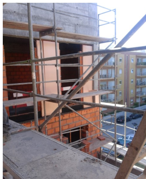
Figura 3.65 - Execução do pano exterior
