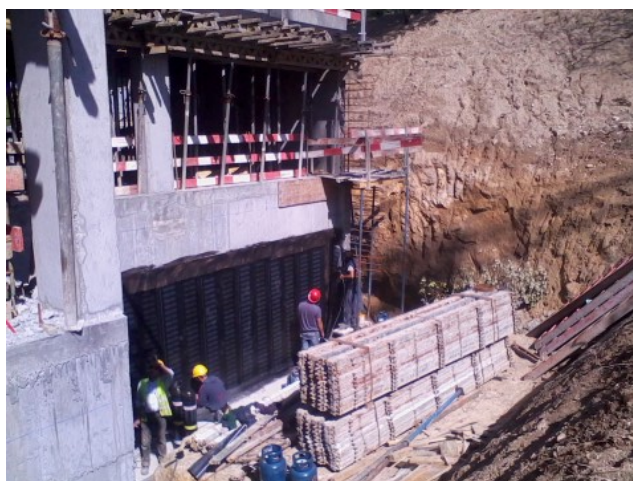
Figura 3.38 - Colocação de telas impermeabilizantes
