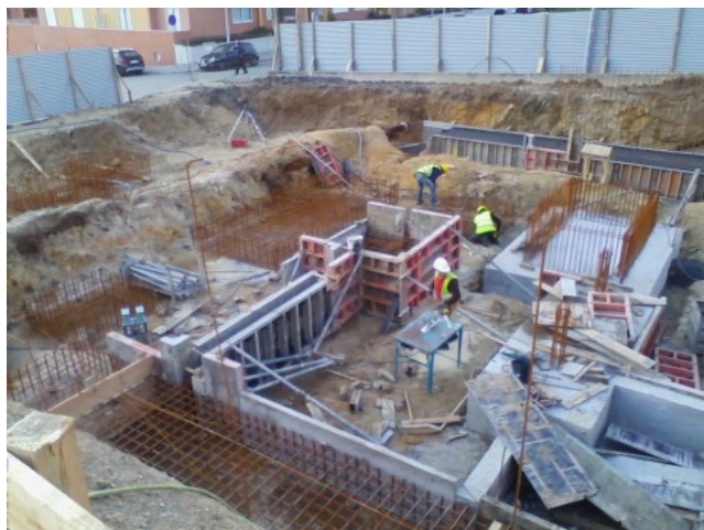
Figura 3.24 – Condução de saneamento
