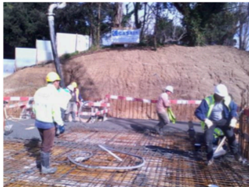
Figura 4 – Início de betonagem na zona este
