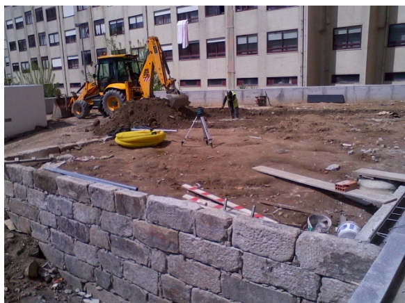
Figura 3.13 - Trabalhos de aterro e compactação da zona exterior a poente
