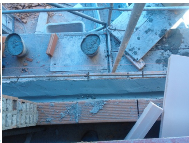
Figura 3.63 - Colocação de armadura
