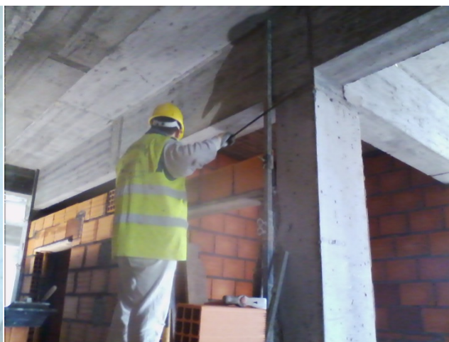
Figura 3.56 - Colocação de aço nas padieiras
