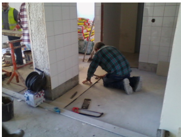
Figura 3.9 - Assentamento de tijoleira
