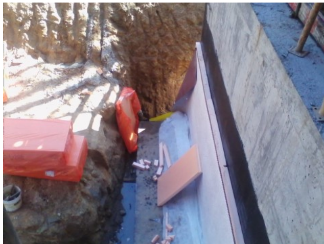
Figura 3.43 - Colocação de isolamento e drenagem sobre as sapatas dos muros
