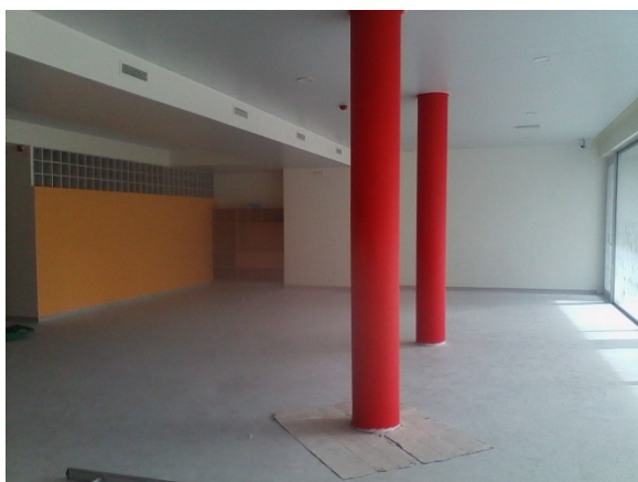
Figura 3.17 - Trabalhos de pintura em espaços interiores
