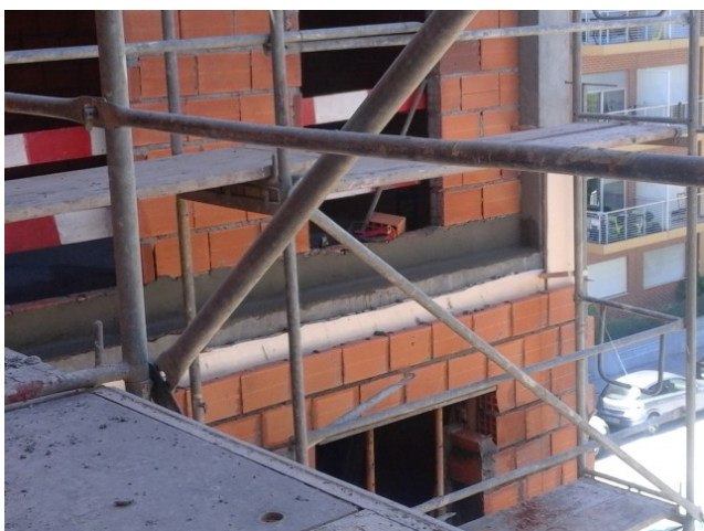
Figura 3.62 - Pano exterior em alvenaria
