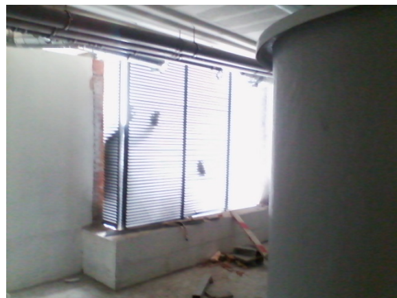
Figura 3.16 - Grelha metálica no canto noroeste no piso -2
