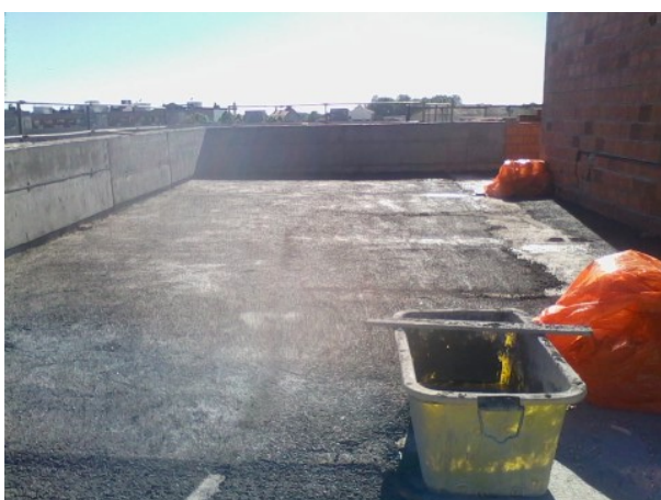
Figura 3.73 - Colocação de betão leve
