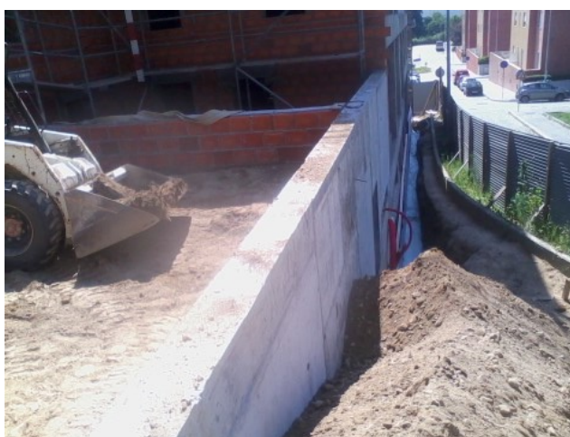
Figura 3.67 - Trabalhos de aterro
