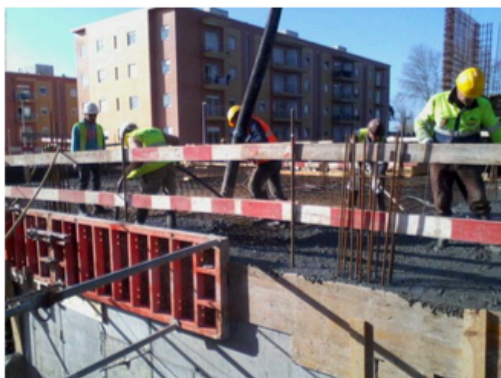
Figura 7 – Continuação da betonagem e vibração
