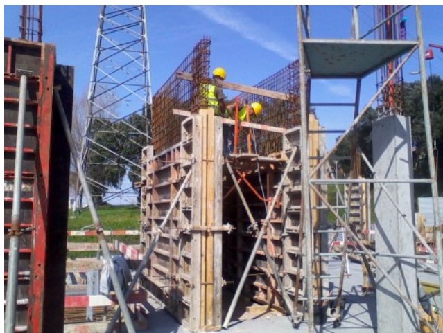
Figura 3.34 – Armação da caixa de elevador
