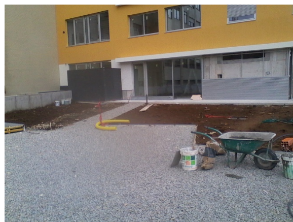
Figura 3.18 - Aplicação de tout-venant e terra vegetal no exterior
