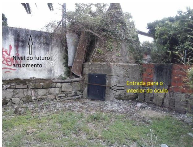
Figura 3.13 – Entrada para Óculo do aqueduto subterrâneo.
