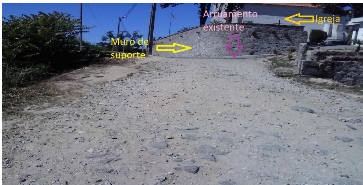
Figura 3.25 – Alguns marcos condicionantes existentes no local de implantação do novo arruamento: Igreja do Paraíso, muro de suporte em alvenaria de pedra, arruamento existente que será mantido.
