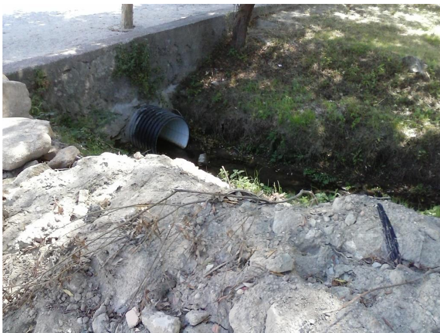
Figura 3.23 – Passagem hidráulica existente (km 0+110).
