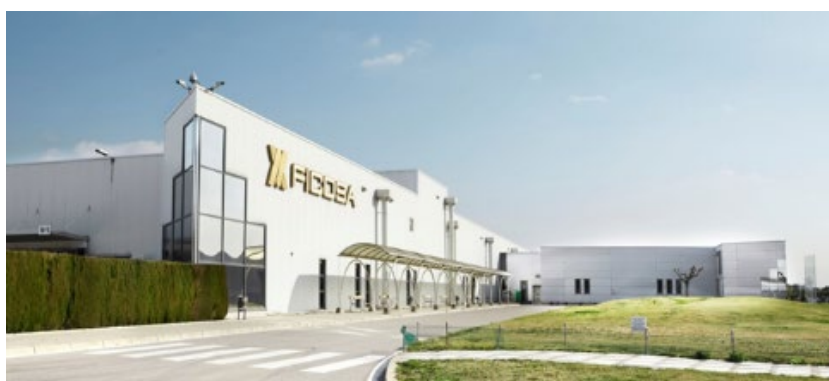
Figura 21 - Sede da empresa e centro de P&D em Barcelona (Espanha)
