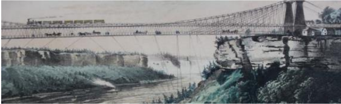
Figura 2.13 – Ponte construída com auxílio aos primeiros tirantes. (12)
