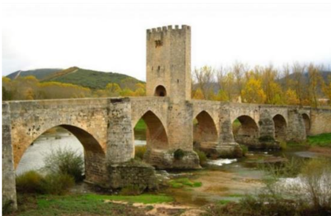
Figura 2.4 - Ponte medieval, Frias, Espanha. (6)
