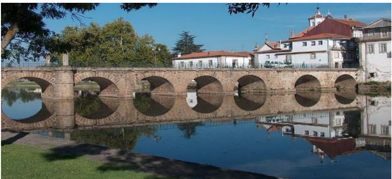
Figura 2.3 – Ponte de Trajano, Chaves, Portugal.
