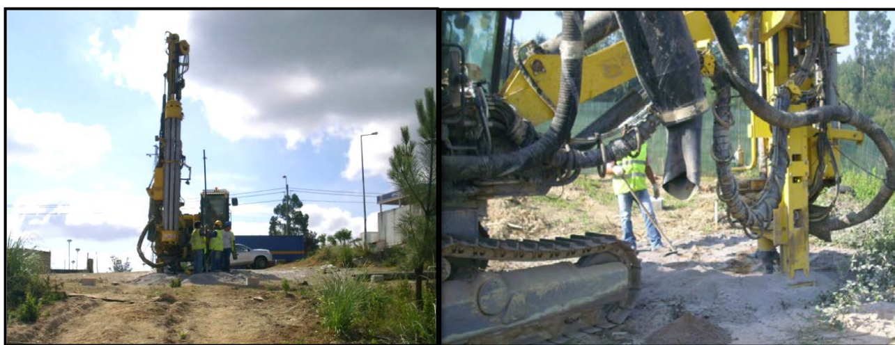
Figura 72 e 73: Execução de um furo para colocação de extensómetro.
