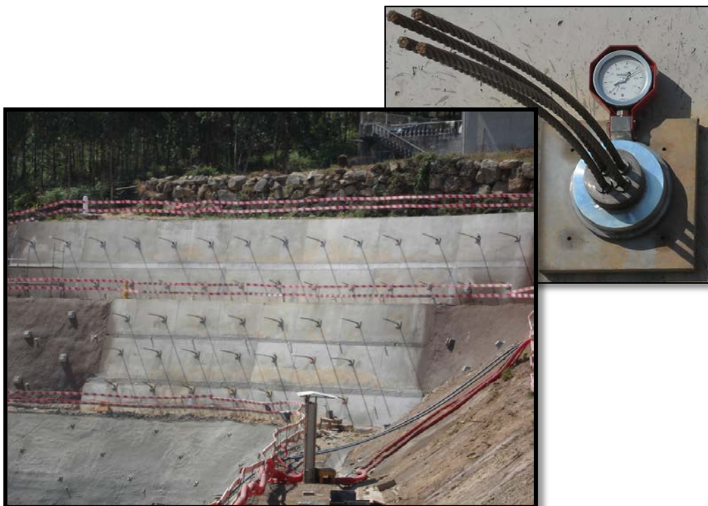
Figura 102: Parede ancorada e célula de carga utilizada.
