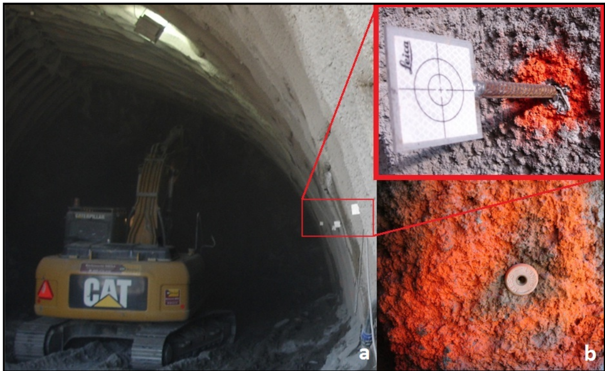
Figura 100: a – Alvos para leitura de convergências no interior do túnel; b – suporte para fixação de primas ou mini-primas.
