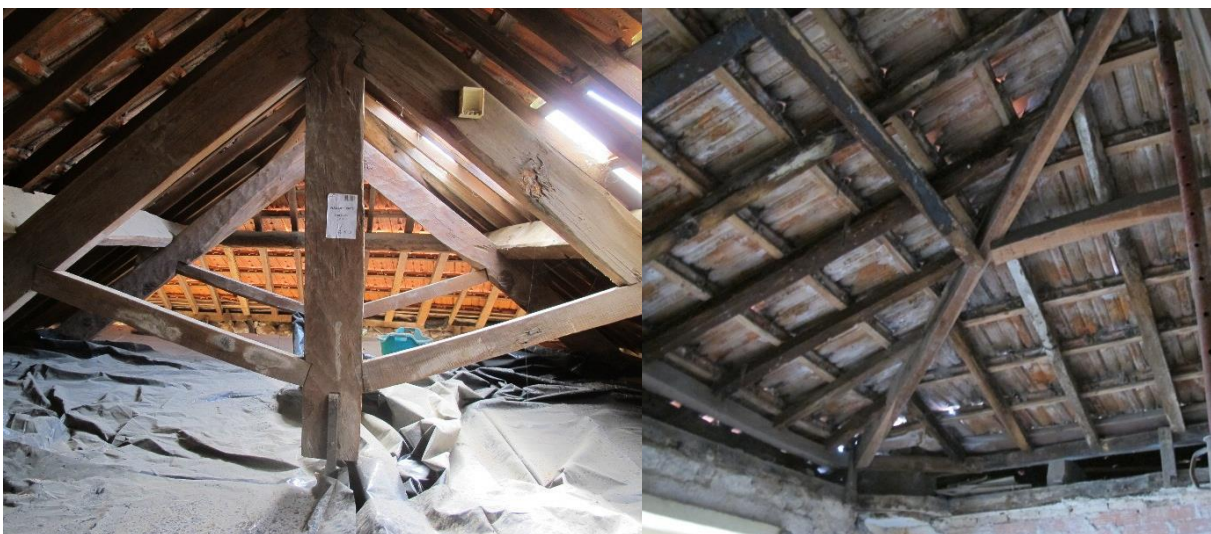
a) Estrutura da cobertura de quatro águas, b) União de águas, (NCREP, 2014l). (NCREP, 2014j).
