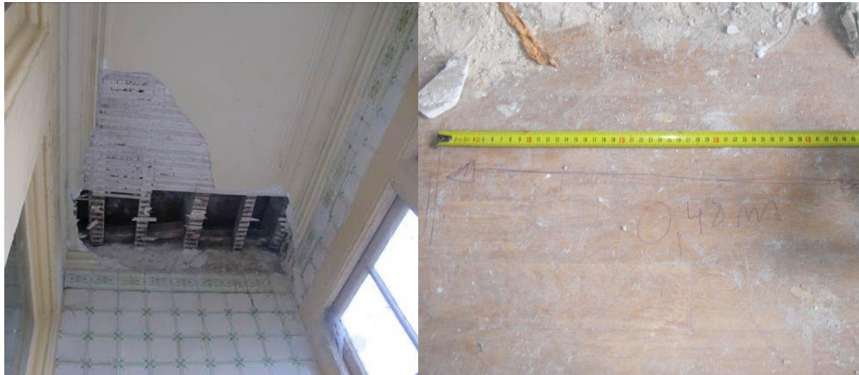
a) Vigas de pavimento observáveis na varanda do piso 2. b) Pormenor do soalho existente no piso 2.
