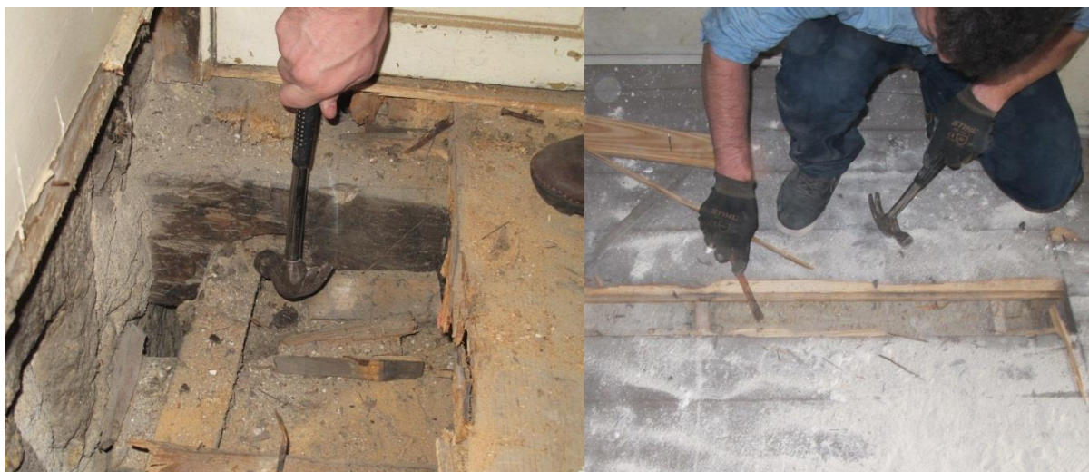
a) Utilização do martelo para detecção de degradações na viga de madeira, (NCREP, 2014l). b) Avaliação do soalho com o formão, (NCREP, 2014g).
