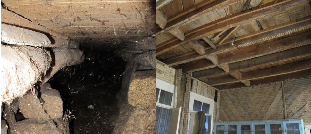
a) Vigamento em madeira no piso térreo, (NCREP, 2014h).
