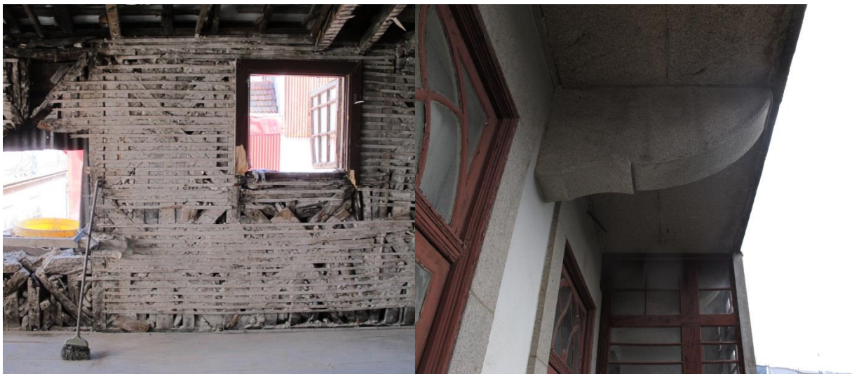
a) Parede de frontal com cruz de St. André, b) Cachorro em pedra de granito na fachada posterior, (NCREP, 2012b).
