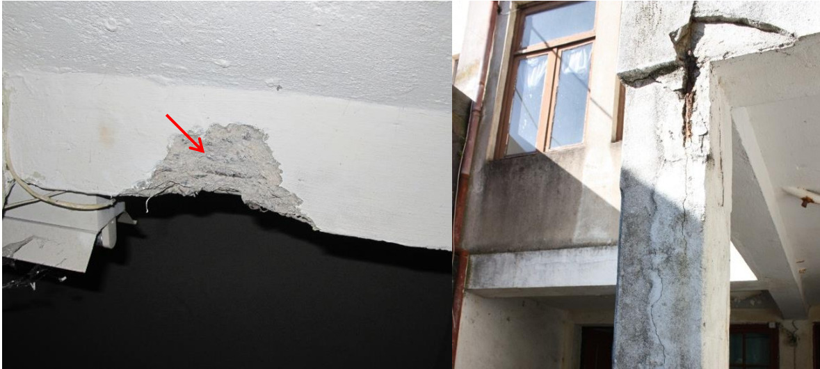
a) Sondagem em viga de betão para levantamento do diâmetro dos varões, (NCREP, 2014g).
