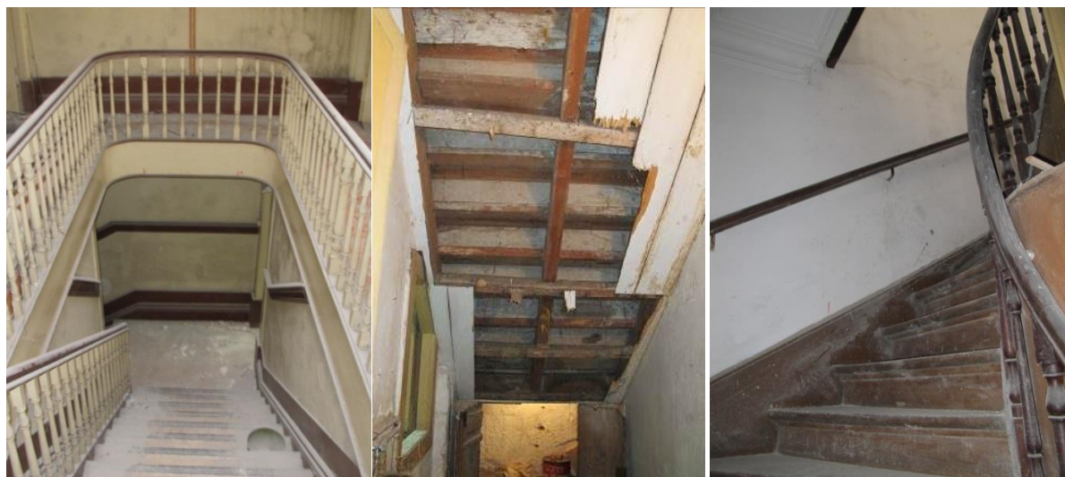
a) Pormenor de escadas de ligação dos pisos 0 e 1.
