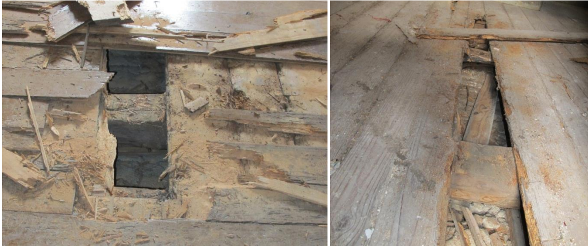
a) Pormenor de viga de pavimento no piso 2.
