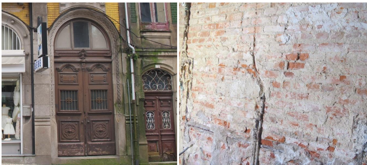
a) Arco em pedra talhada, (NCREP, 2014g). b) Paredes em tijolo maciço no último piso, (NCREP, 2014l).
