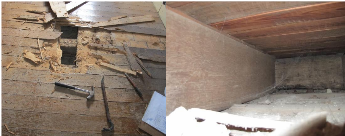
a) Sondagem no pavimento do piso 2 no Edifício Rua da Torrinha.
