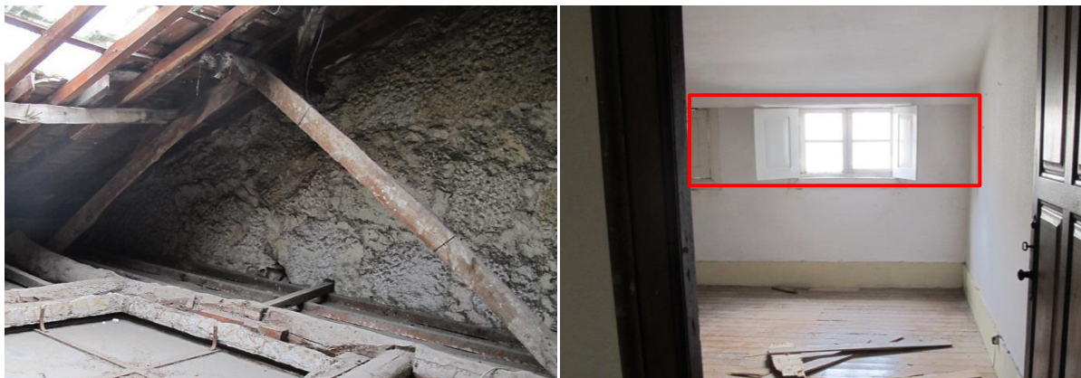
a) Alvenaria visível no desvão da cobertura.
