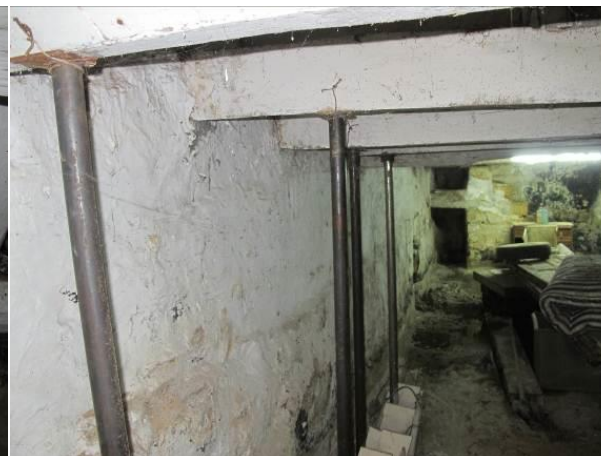
d) Vigas de secção rectangular escoradas.
