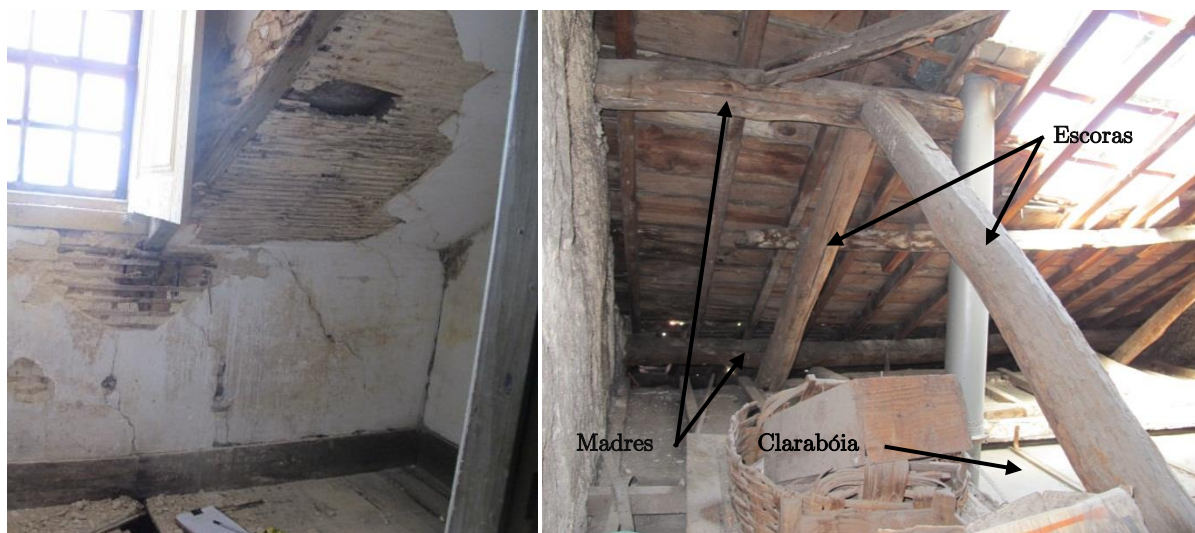
a) Mansarda existente no piso 3.
