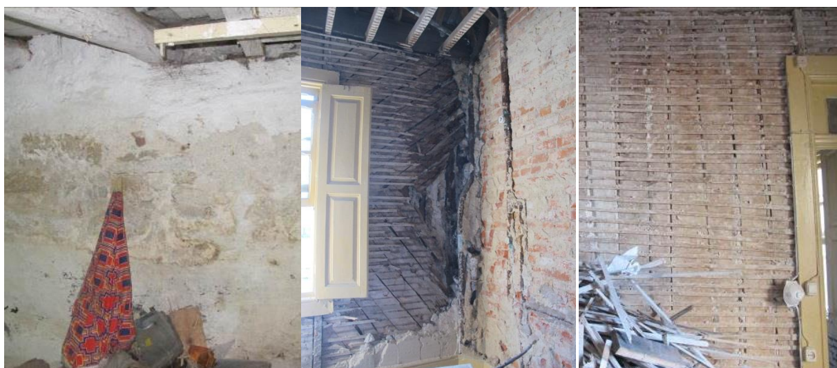
a) Empena de alvenaria de pedra em granito visível no piso -1. b) Tabique duplo e alvenaria de tijolo maciço no piso 2. c) Tabique simples de compartimentação no piso 2.
