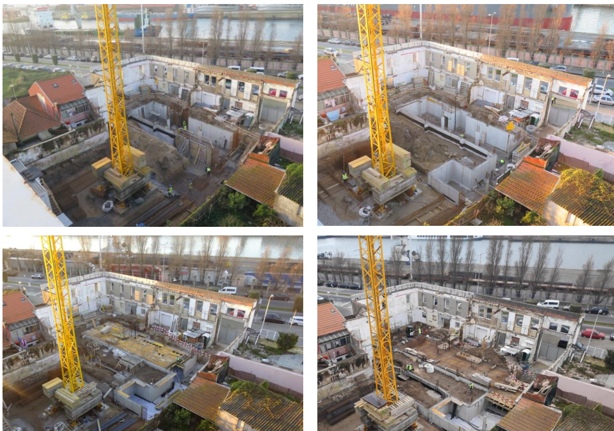
Figura 4.44- Processo de betonagem da laje do piso -1
