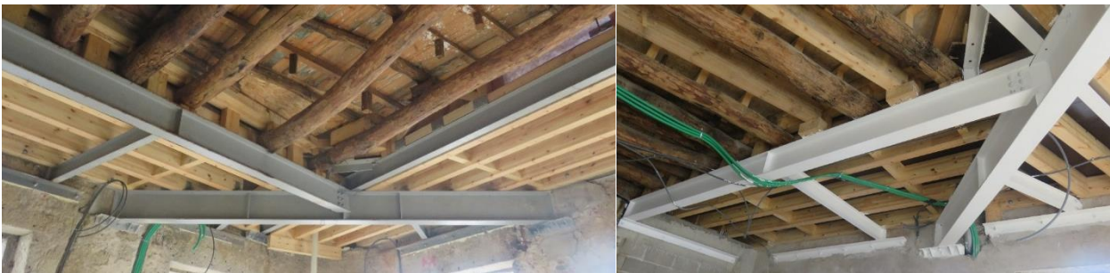
a) Antes da aplicação da pintura (cor original do perfil, cinzento)
