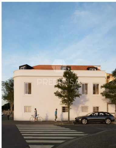
c) Vista do edifício a partir da Rua Roberto Ivens
