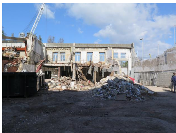
b) Continuação dos trabalhos de demolição
