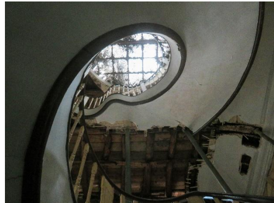
b) Escoras metálicas colocadas para reforçar a segurança estrutural
