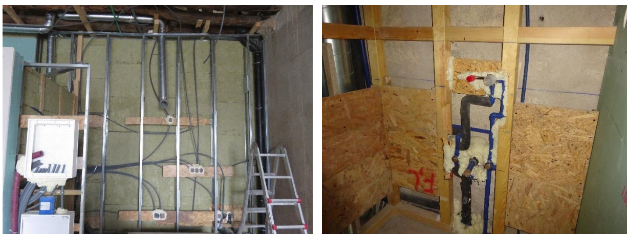
a) Verificação do traçado da rede elétrica
