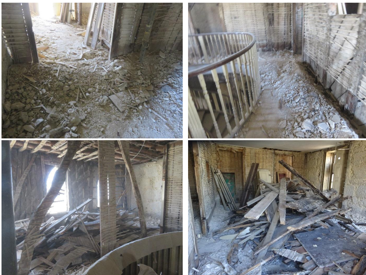
Figura 4.20- Fase de demolição das paredes de tabique
