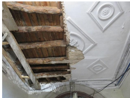
b) Escoramento provisório do teto
