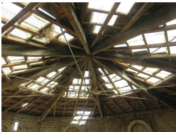
a) Estado inicial da cobertura A
