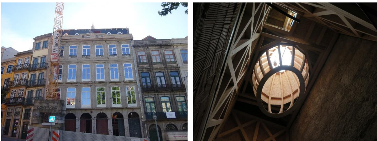
Figura 4.55- Acompanhamento do desenvolvimento dos trabalhos da obra situada na Rua de Mouzinho da Silveira
