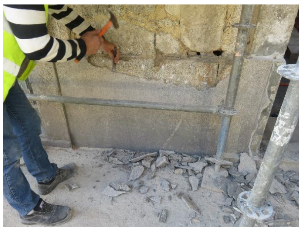
a) Remoção da capa de argamassa sobre a alvenaria de pedra
