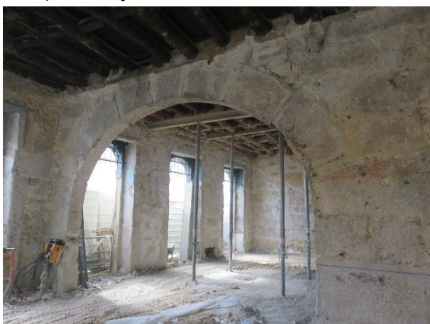
c) Pavimento térreo antes da betonagem
