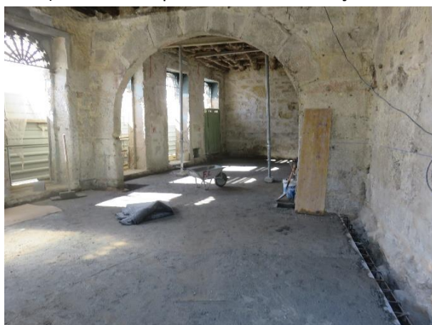
d) Betonagem do pavimento térreo
