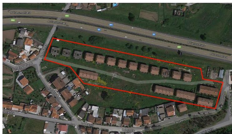
Figura 3.2- Localização do empreendimento junto à autoestrada A4 [15]
