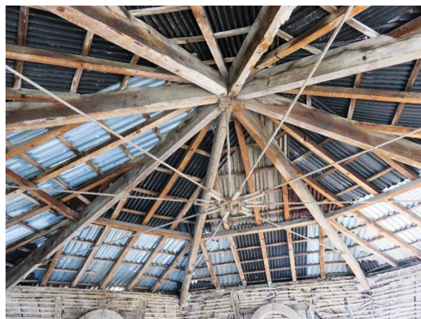
b) Levantamento da telha e substituição por chapas metálicas
