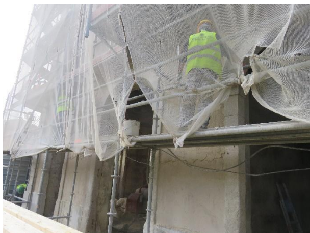
a) Aplicação da argamassa de acabamento
