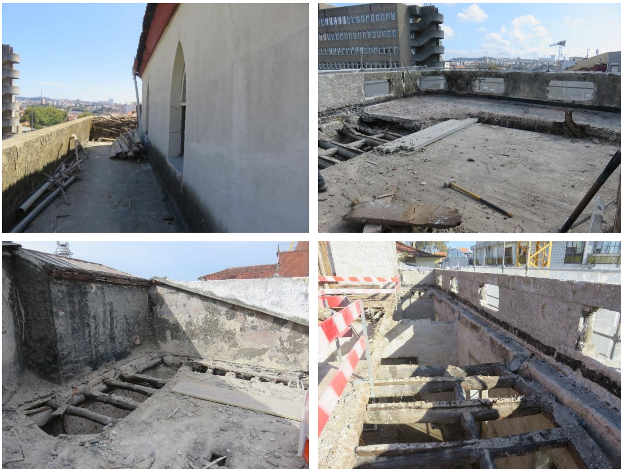
Figura 4.29- Desenvolvimento dos trabalhos de demolição da cobertura C (verificar Fig. 4.27)
