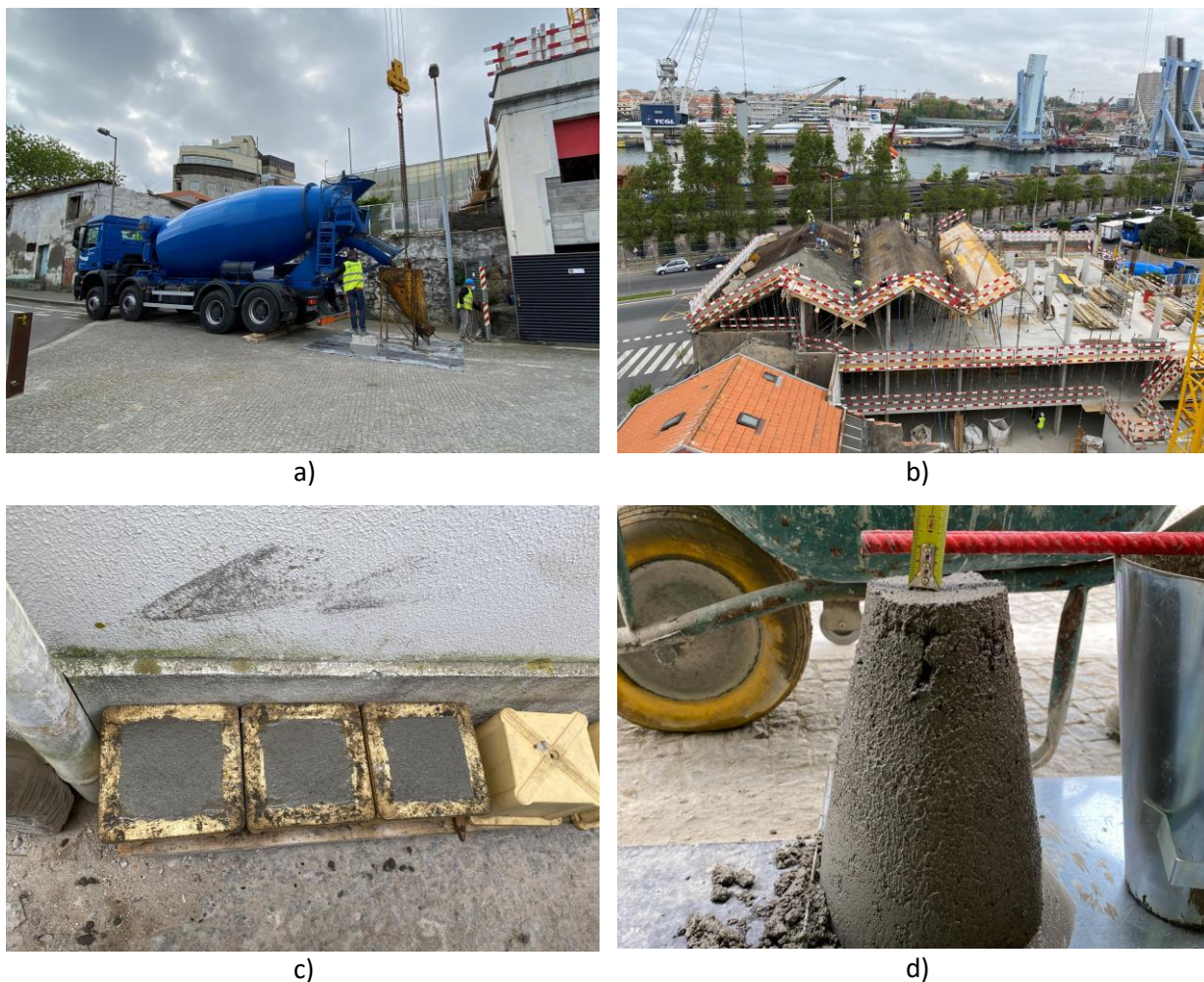
Figura 4.53- Processo de betonagem da laje da cobertura do edifício
