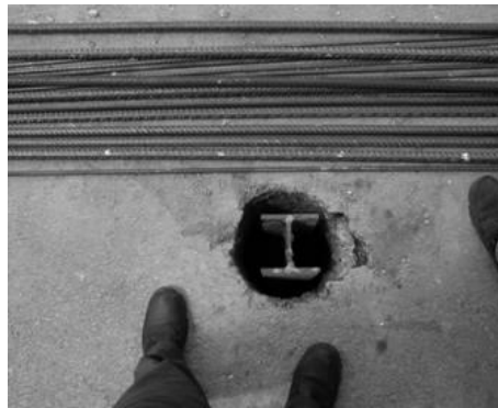
Figura 4.41- Introdução dos perfis metálicos no terreno [64]
