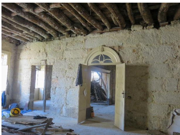
a) Parede divisória interior em alvenaria de pedra
