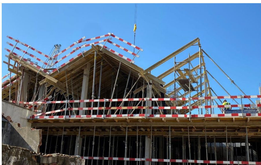
Figura 4.48- Montagem da cofragem da cobertura inclinada
