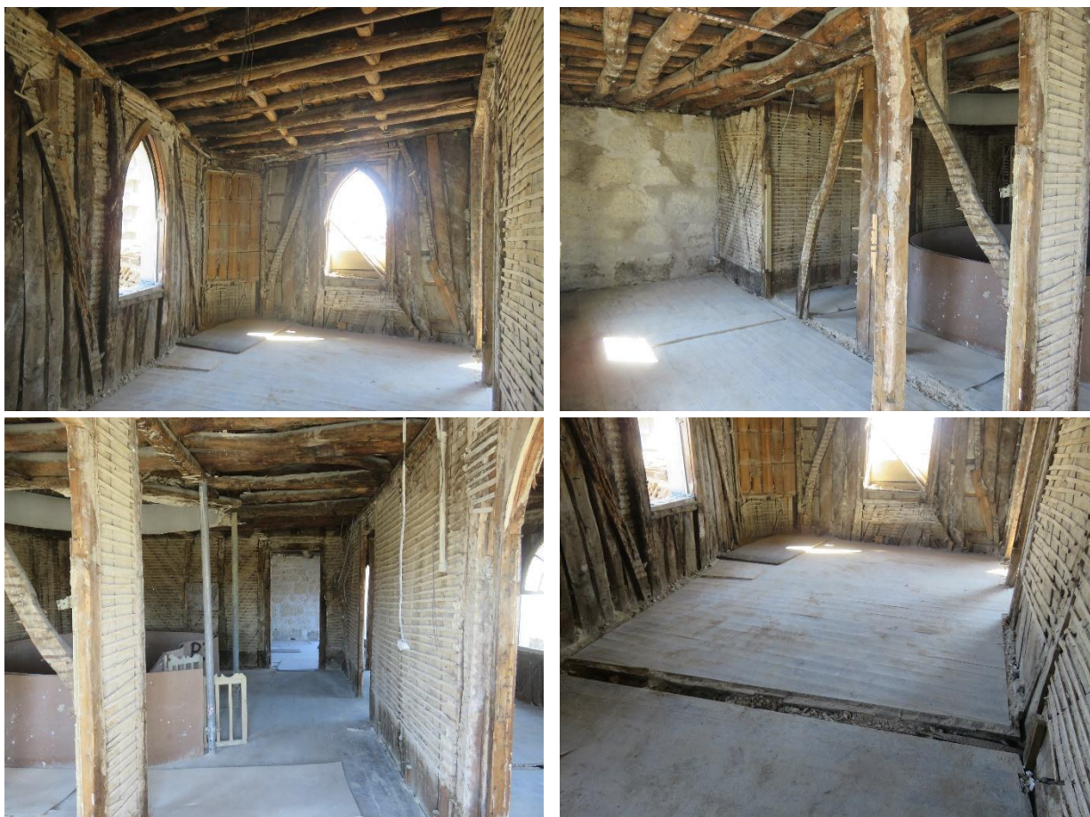
Figura 4.21- Limpeza da frente de trabalho
