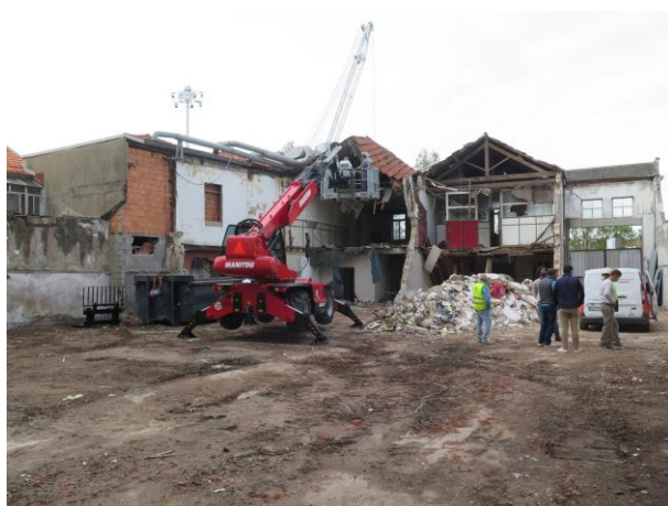
a) Início dos trabalhos de demolição
