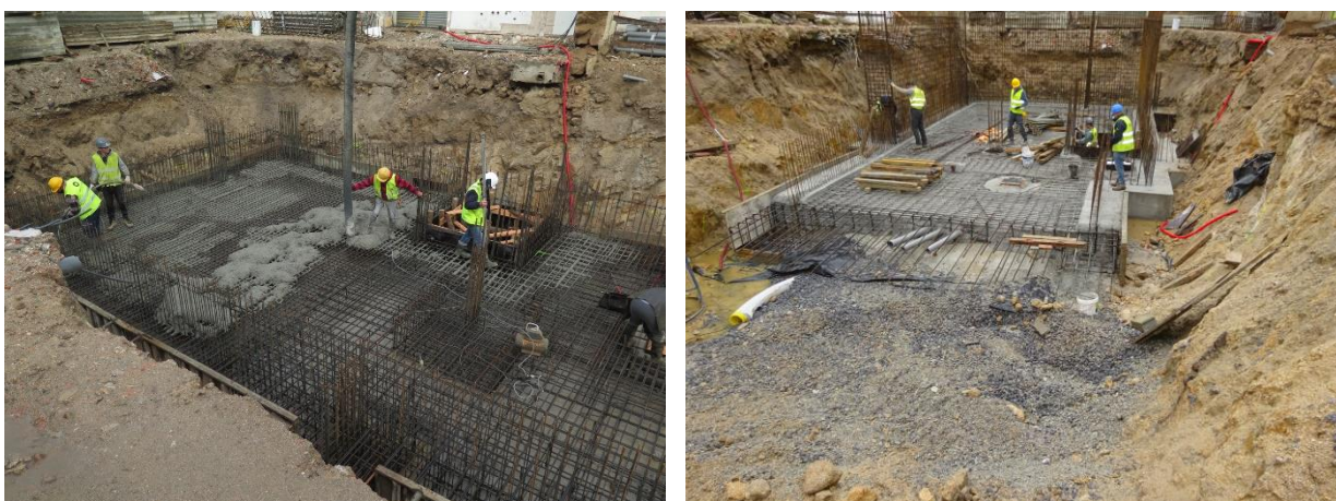
Figura 4.38- Betonagem do ensoleiramento geral ao nível do piso -1
