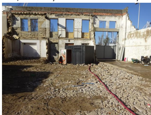
d) Fase final dos trabalhos de demolição
