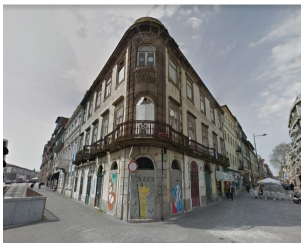
b) Vista sobre as duas fachadas do edifício
