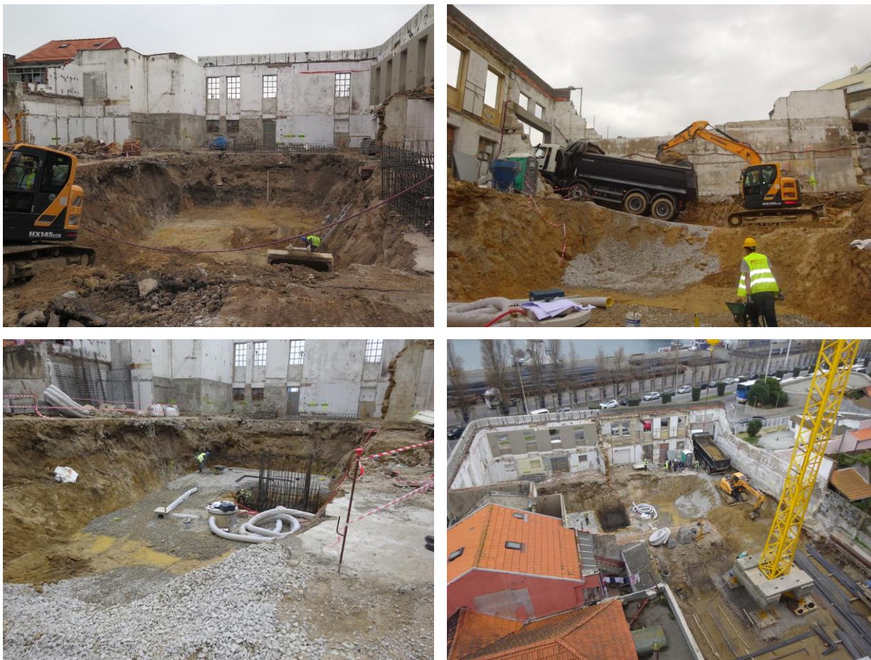
Figura 4.37- Trabalhos de movimentação de terras de início de fundações
