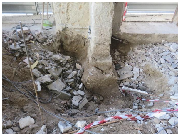
a) Execução de cabouco
