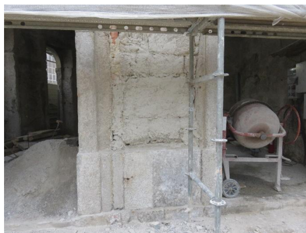
b) Parede de fachada após o processo de picagem
