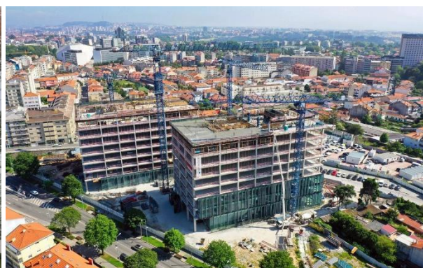
b) Edifícios durante a fase de execução [14]
