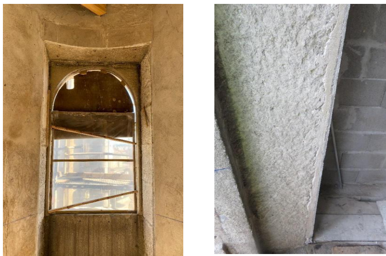
Figura 4.18- Reboco aplicado na face interior das alvenarias de pedra
