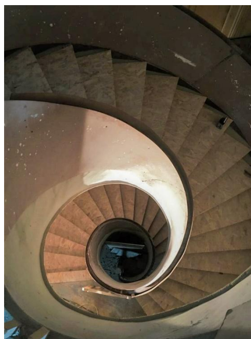
b) Proteção do guarda-corpos e dos cobertores dos degraus
