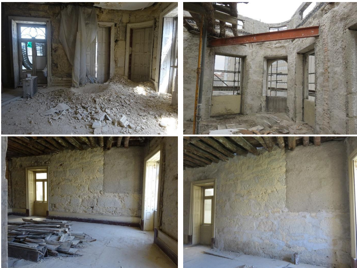
Figura 4.17- Processo interventivo nas alvenarias de pedra
