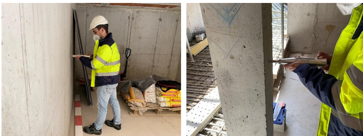
Figura 4.52- Registo da realização do ensaio esclerométrico pelo autor
