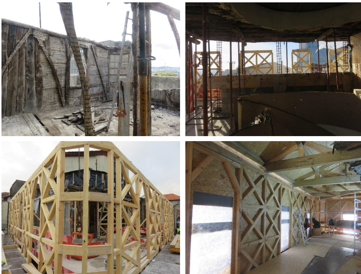
Figura 4.30- Novas paredes em frontal de madeira do piso 3
