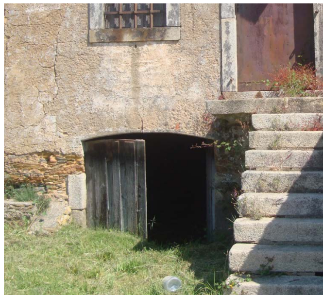
Figura 13 - Entrada para a zona das futuras instalações sanitárias e armazém
