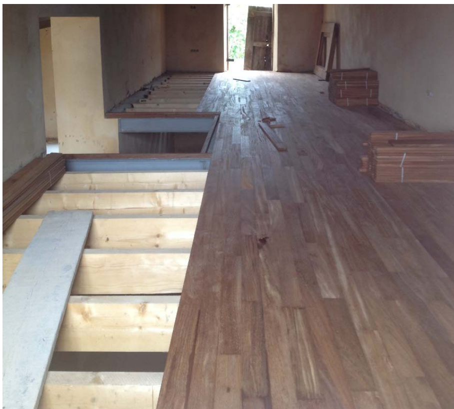
Figura 55 - Aplicação dos soalhos
