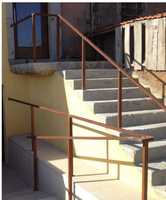
Figura 63 - Guarda exteriores antes do acabamento
