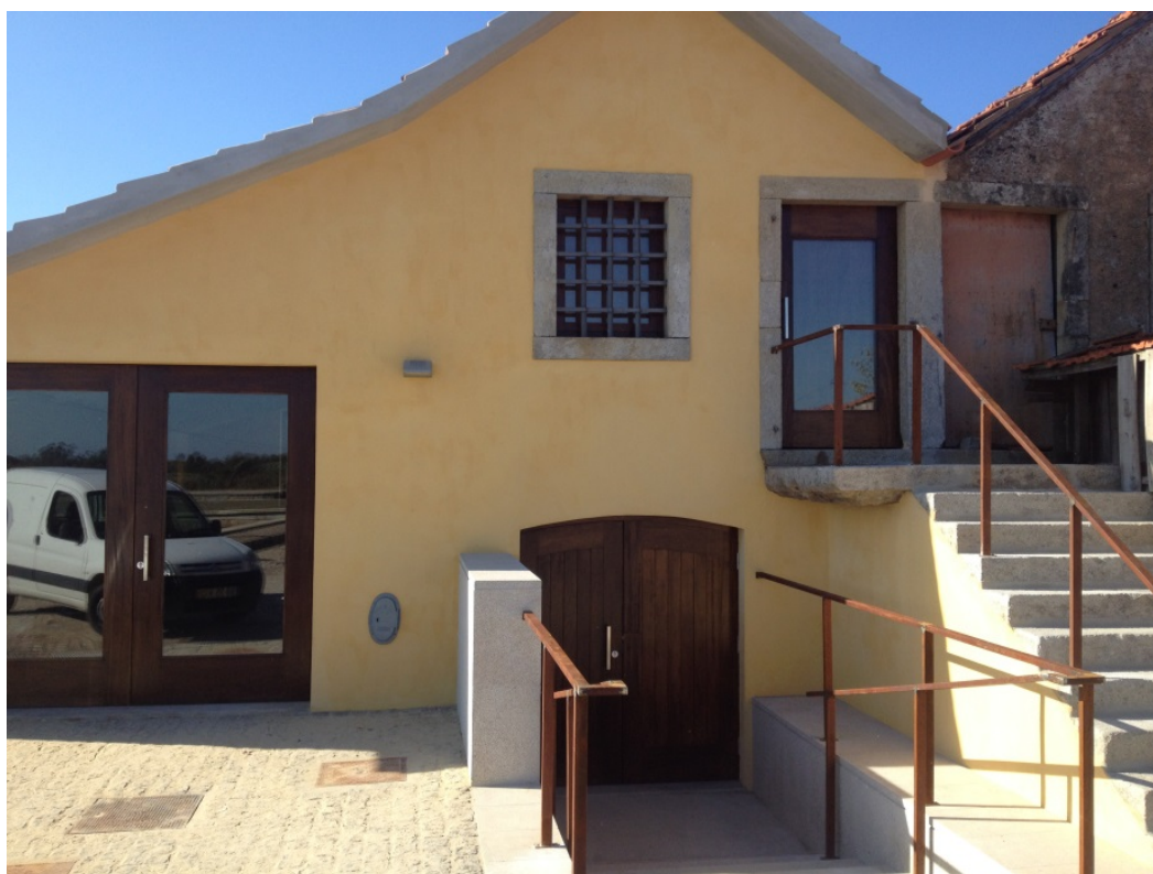
Figura 94 - Fachada principal do edifício
