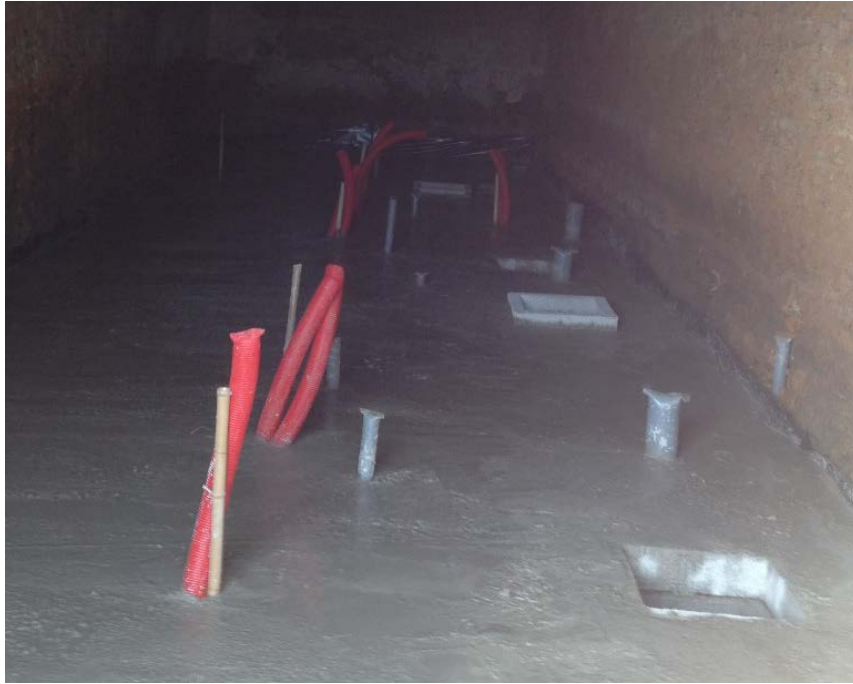
Figura 88 - Instalação da rede de abastecimento
