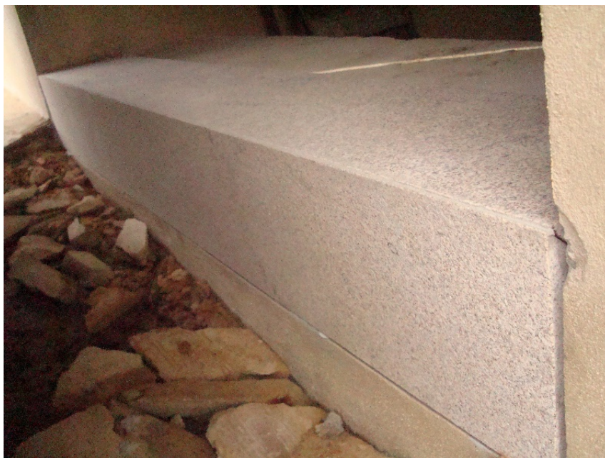
Figura 59 - Colocação das pedras de granito em soleiras
