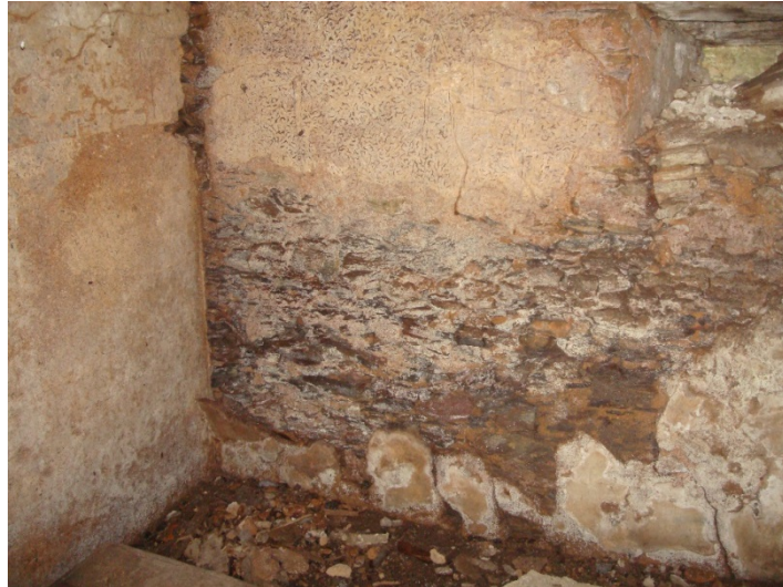
Figura 40 - Estado da parede existente
