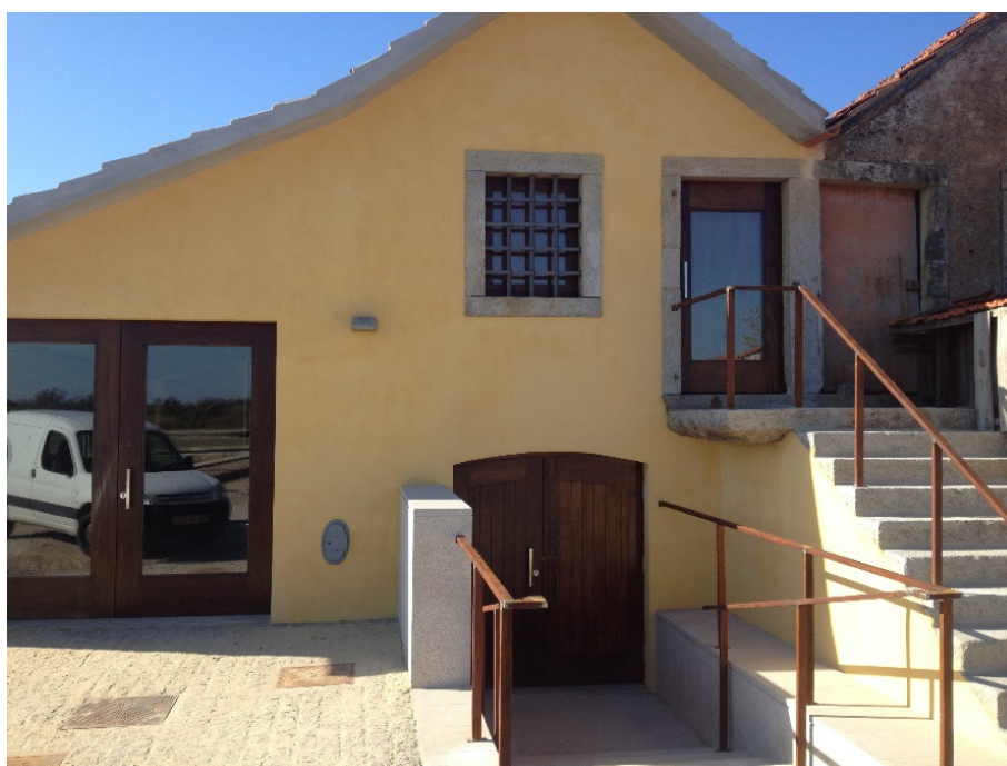
Figura 65 - Portas exteriores em madeira
