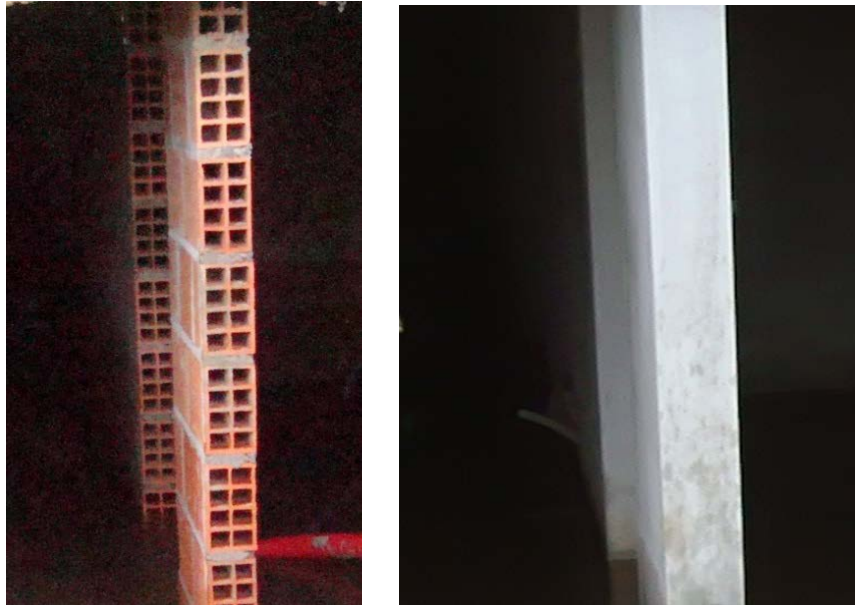
Figura 43 - Parede divisória das instalações sanitárias
