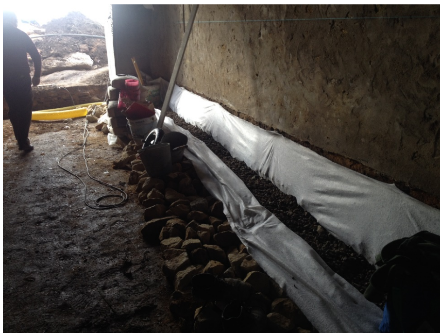
Figura 53 - Fase de execução do pavimento interior
