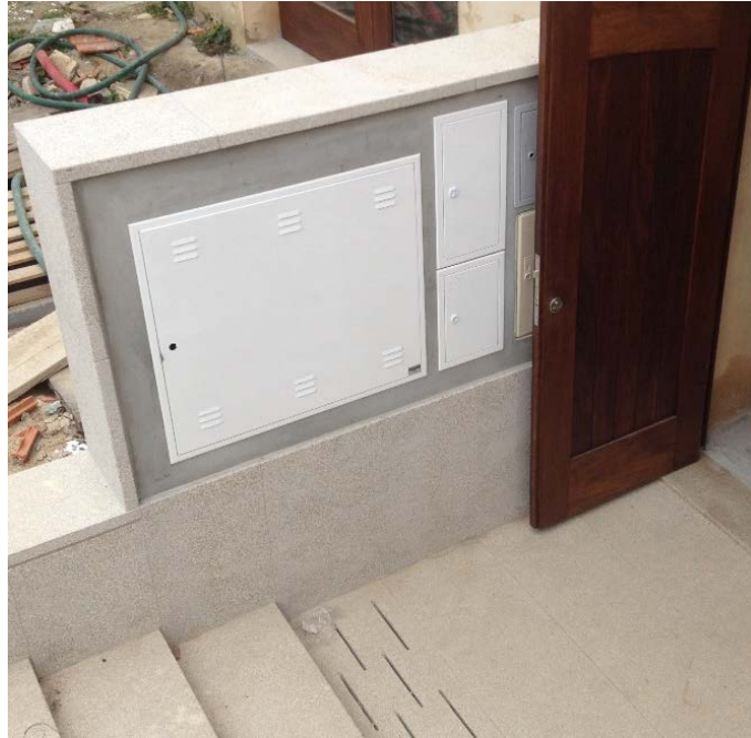
Figura 60 - Colocação das pedras de granito nos contadores e pavimentos
