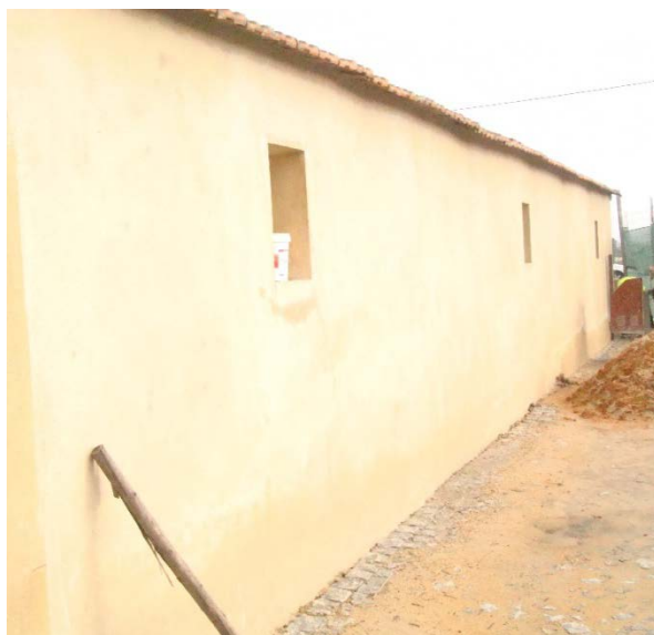
Figura 69 - Pintura parede exterior
