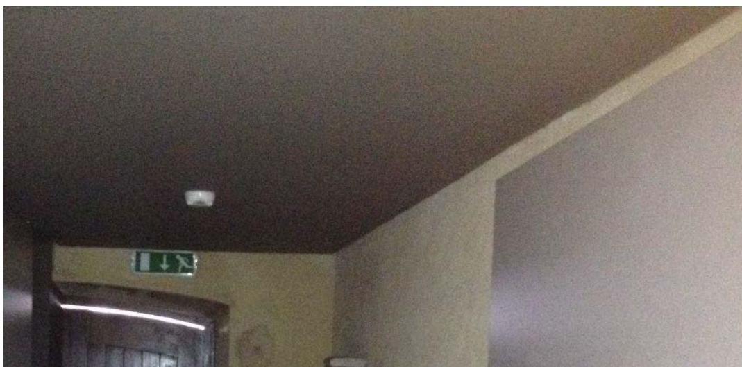
Figura 47 - Aspeto final do teto falso
