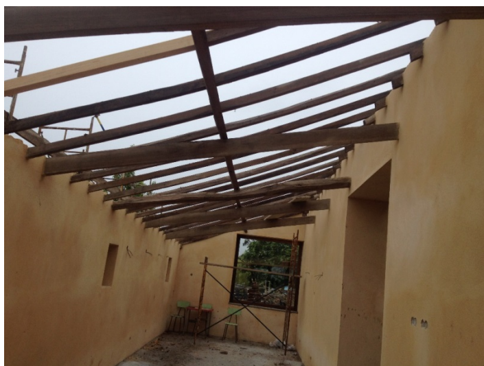
Figura 39 - Remoção da cobertura
