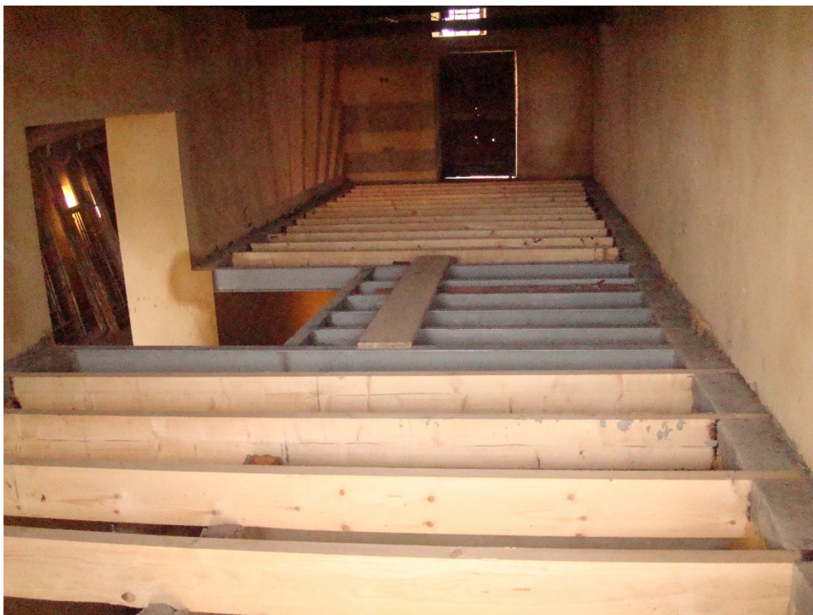
Figura 54 - Colocação das novas vigas
