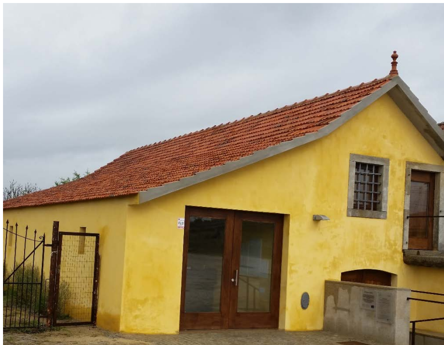
Figura 52 - Aspeto final da cobertura
