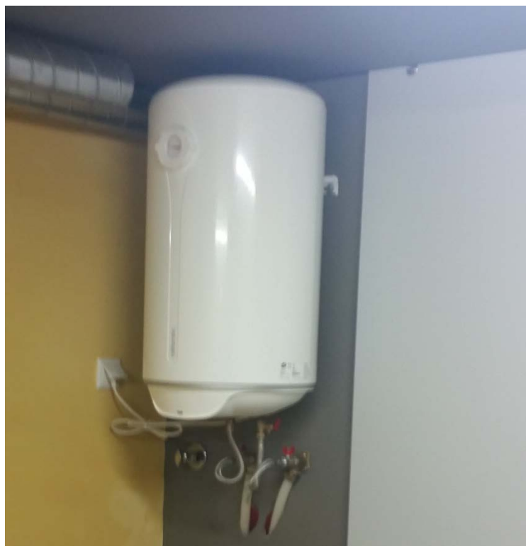
Figura 89 - Instalação do termoacumulador
