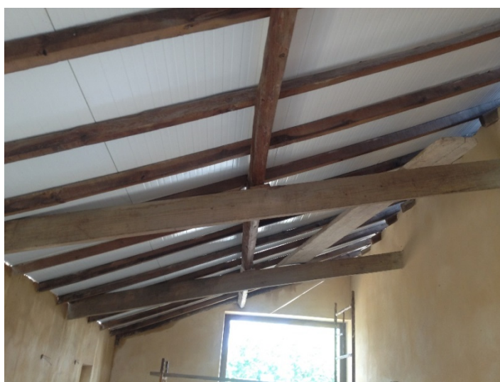
Figura 50 - Colocação dos painéis sandwich sobre os elementos existentes recuperados
