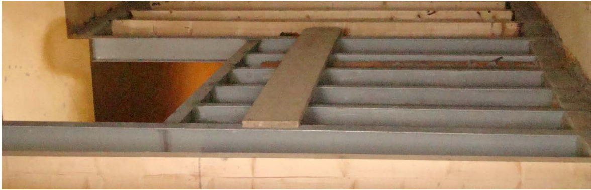
Figura 78 - Estrutura de apoio da escada metálica
