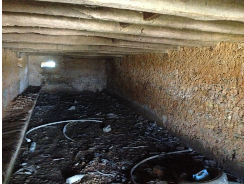
Figura 12 - Compartimento das futuras instalações sanitárias e do armazém
