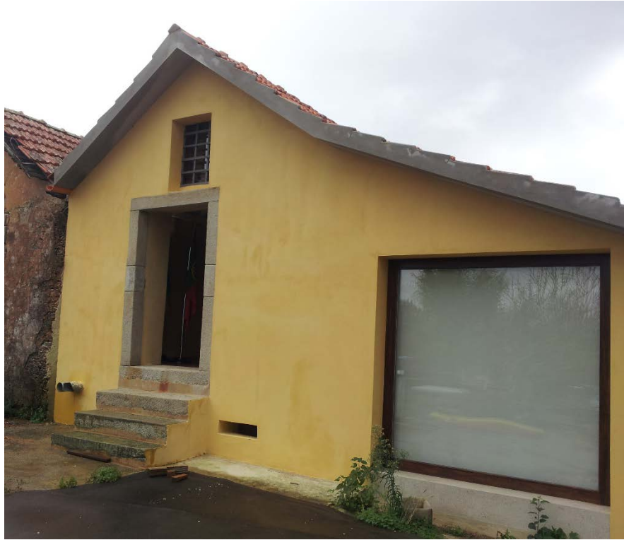
Figura 95 - Fachada traseira do edifício
