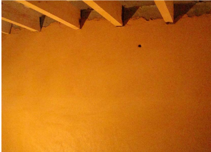
Figura 41 - Acabamento final das paredes
