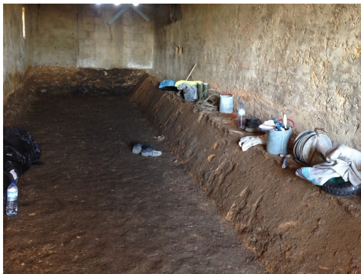
Figura 36 - Remoção do pavimento interior
