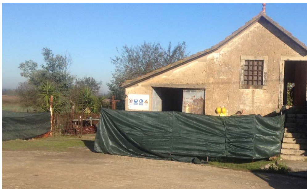
Figura 34 - Vedação do edifício
