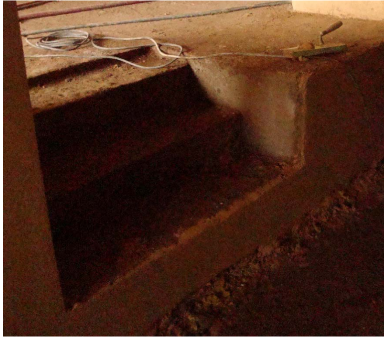
Figura 76 - Escadas interiores em betão
