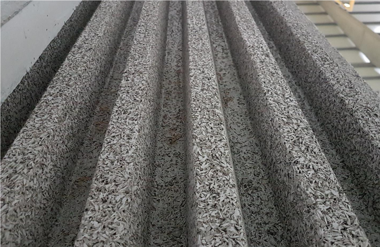
Figura 3-6 – Barreira Acústica de betão e casca de arroz;
