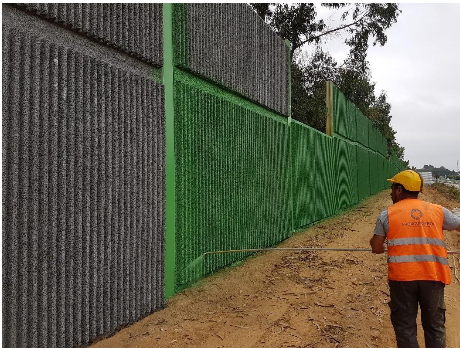
Figura 4-19- Pintura dos painéis acústicos in situ;
