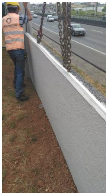
Figura 4-18 – Aplicação de painéis acústicos com borracha tipo EPDM;
