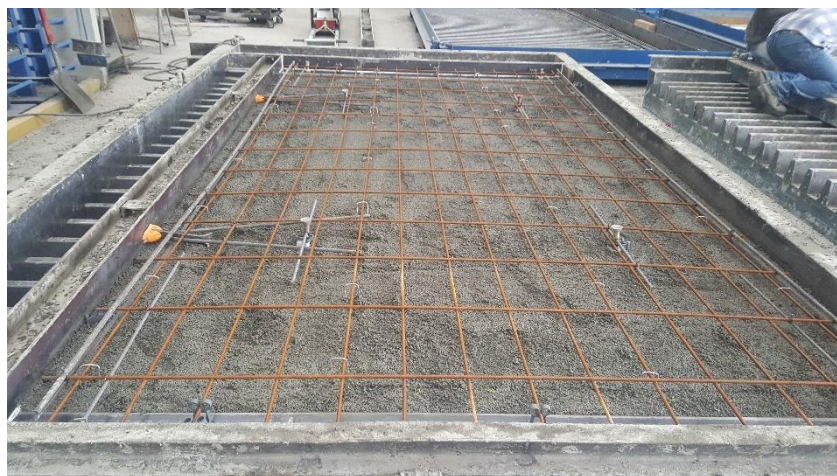
Figura 4-8 – Exemplo de disposição de armadura e acessórios;
