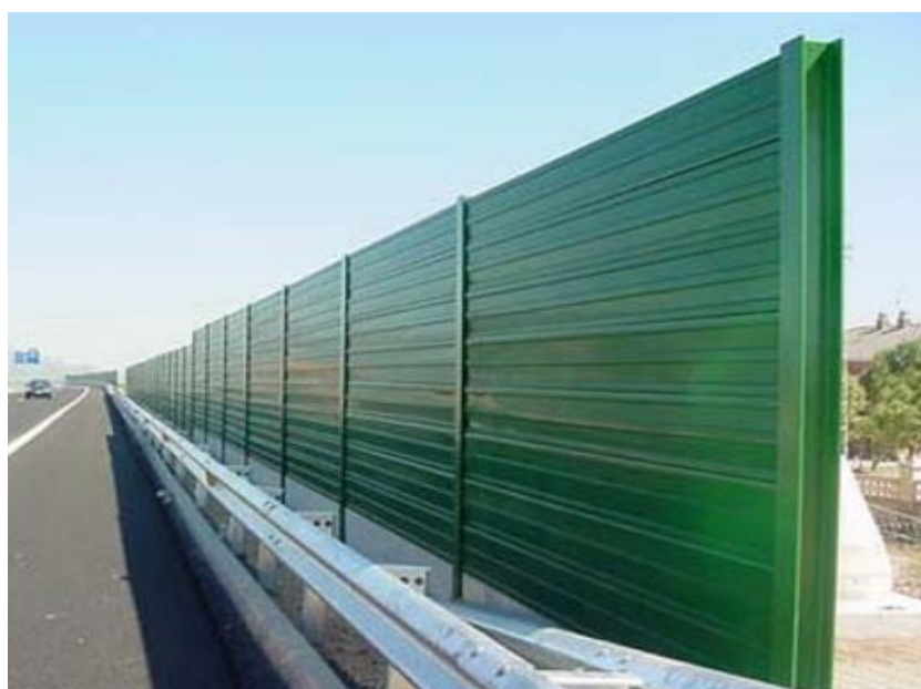
Figura 3-4 – Painéis Metálicos (Barreto, 2004);
