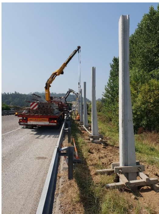
Figura 4-14 – Aplicação de pilares pré-fabricados através de camião grua;
