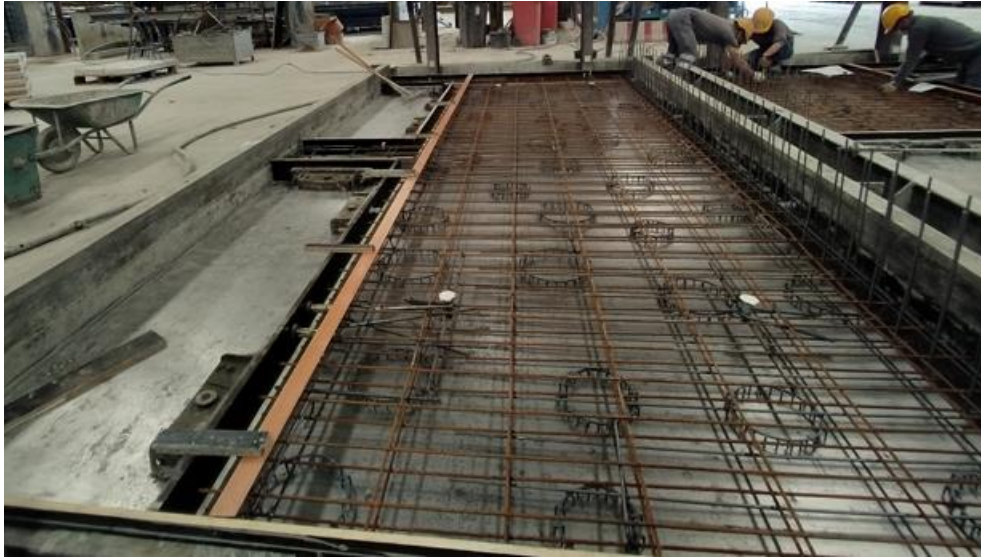
Figura 2-7- Preparação estrutural do elemento;
