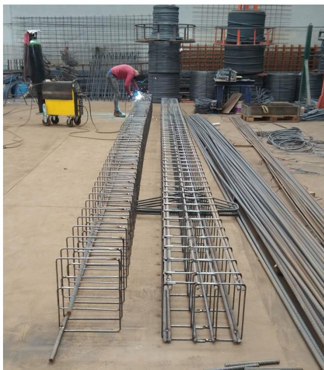
Figura 2-6- Processo de soldadura de armaduras;
