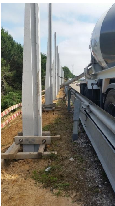
Figura 4-15 – Betonagem da fundação;
