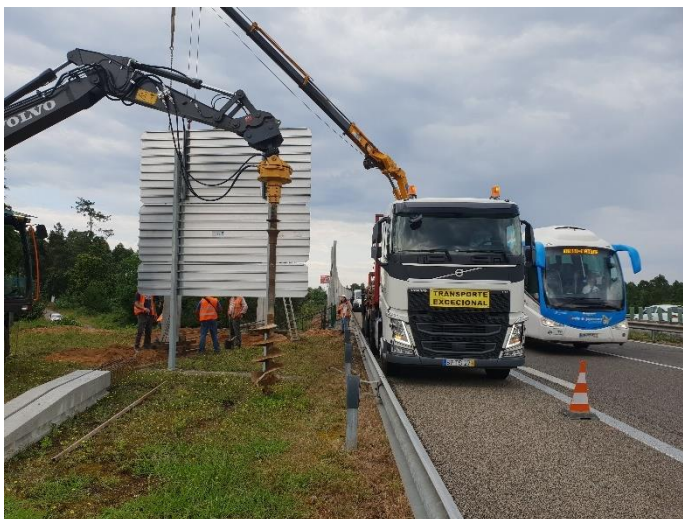
Figura 4-13 – Execução de estacas com trado hidráulico;
