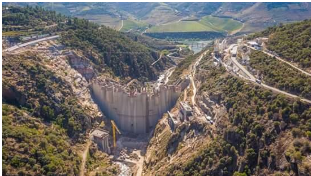
Vista aérea de montante, (SkyEye, 2015)
