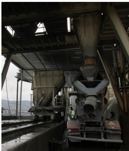
Figura 37 – Silobus e autobetoneira
