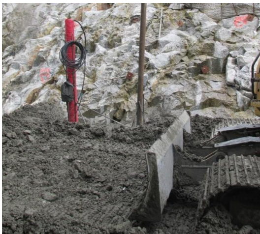
Figura 89 – Espalhamento de betão
