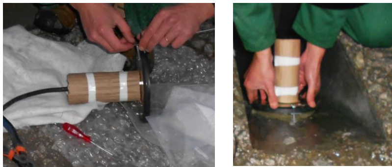
Figura 71 – Instalação da CT num plano inclinado
