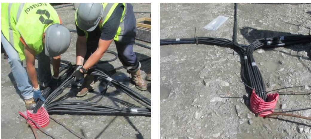
Figura 76 – Condução dos cabos para a conduta técnica
