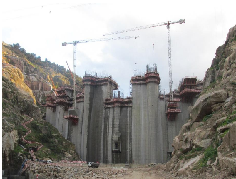
Vista de montante
