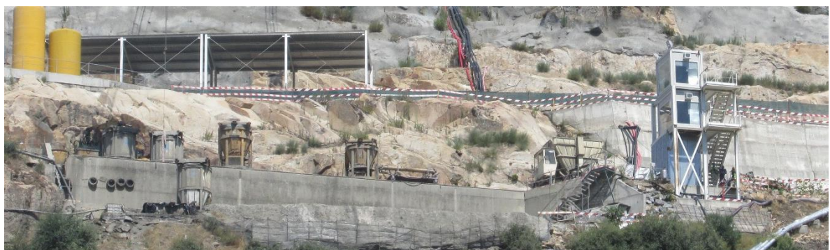
Figura 48 – Localização do cais de baldes junto à cabine de controlo do blondin
