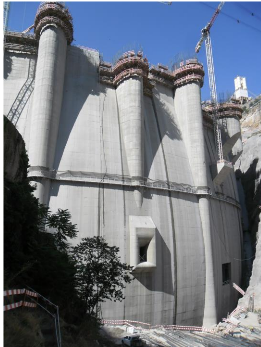
Vista de montante
