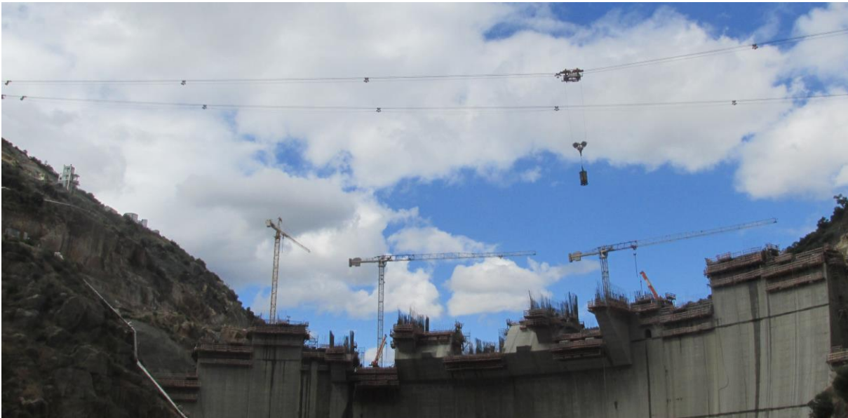
Figura 77 – Transporte de betão
