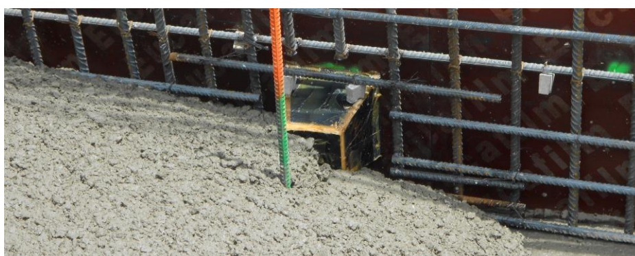
Figura 87 – Betonagem de um termómetro de água
