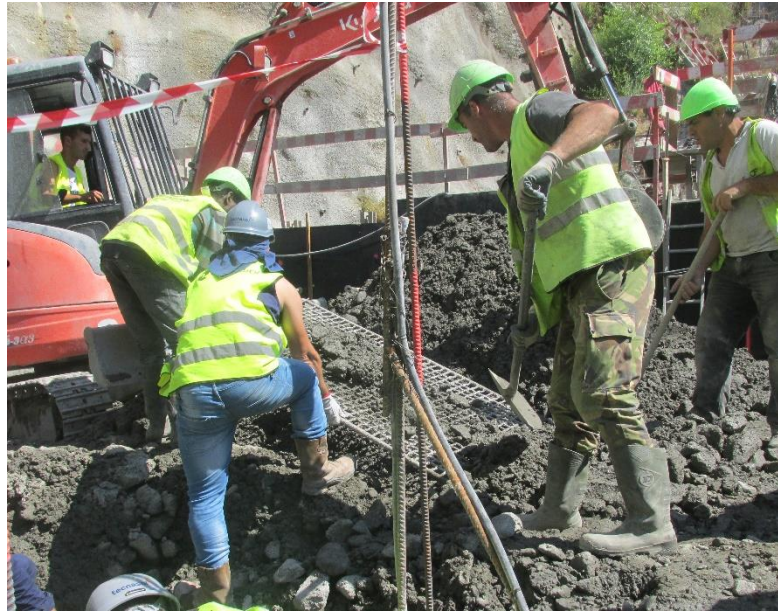
Figura 80 – Crivagem do betão para envolvimento dos extensómetros de resistência
