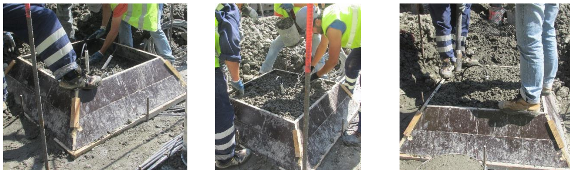
Figura 83 – Enchimento e vibração do betão a colocar no segundo elemento de cofragem para envolvimento do grupo tridimensional de extensómetros de resistência
