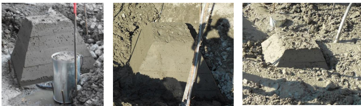
Figura 85 – Descofragem da pirâmide e envolvimento em betão
