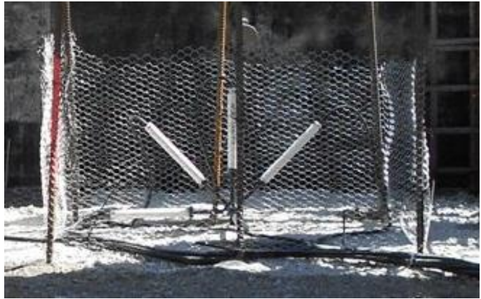
Figura 63 – Instalação de um grupo plano de extensómetros de resistência com recurso à rede de galinheiro
