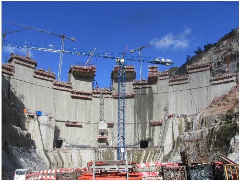
Vista de jusante
