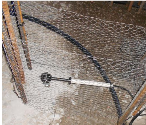
Figura 62 – Instalação de um grupo unidirecional de extensómetros de resistência com recurso à rede de galinheiro
