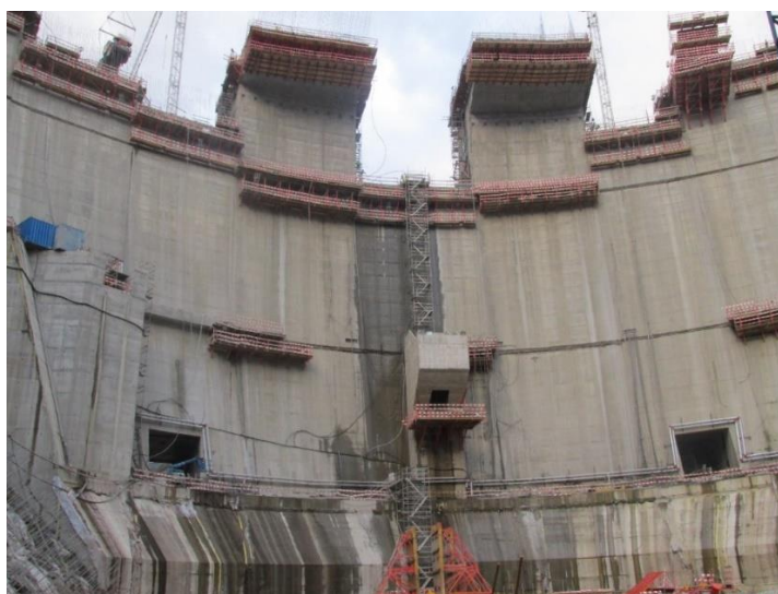
Figura 43 – Orifícios provisórios da estrutura da barragem
