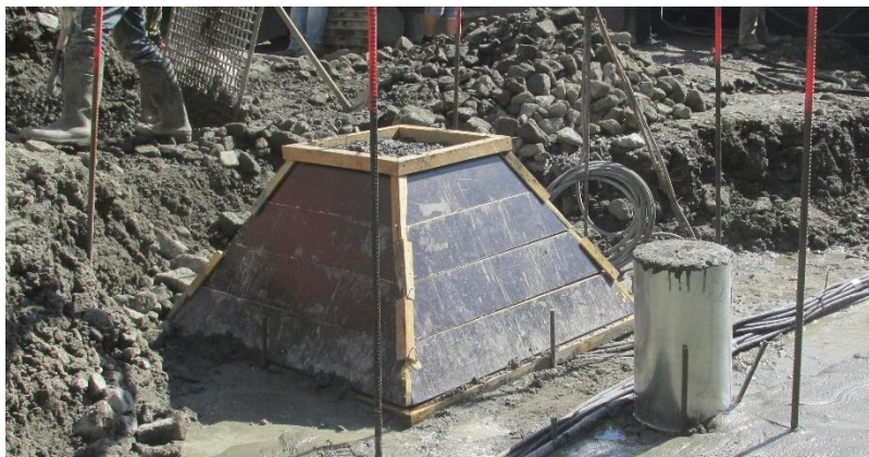
Figura 84 – Pirâmide completamente preenchida de betão
