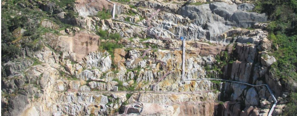
Figura 50 – Encostada escavada da margem esquerda
