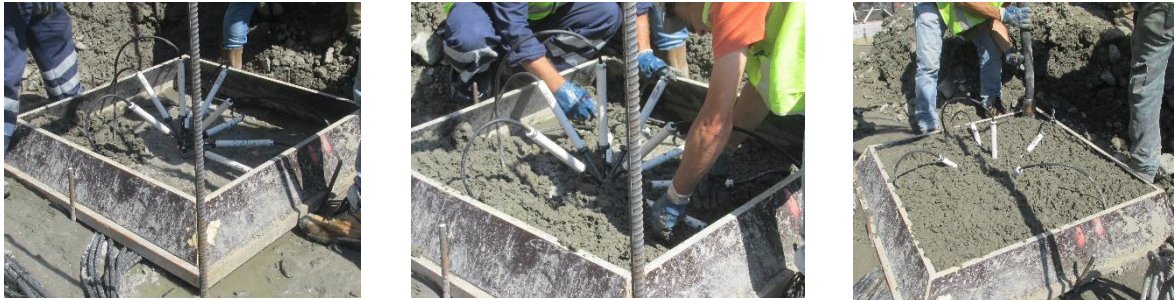
Figura 82 – Enchimento e vibração do betão a colocar no primeiro elemento de cofragem para envolvimento do grupo tridimensional de extensómetros de resistência
