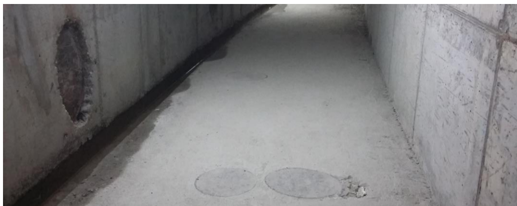
Figura 98 – Tubagem existente na GV para finalizar a betonagem dos orifícios provisórios
