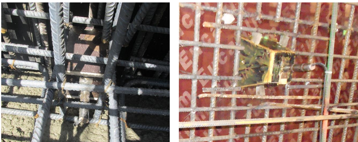
Figura 66 – Cofragem quadrangular para instalação do termómetro de água
