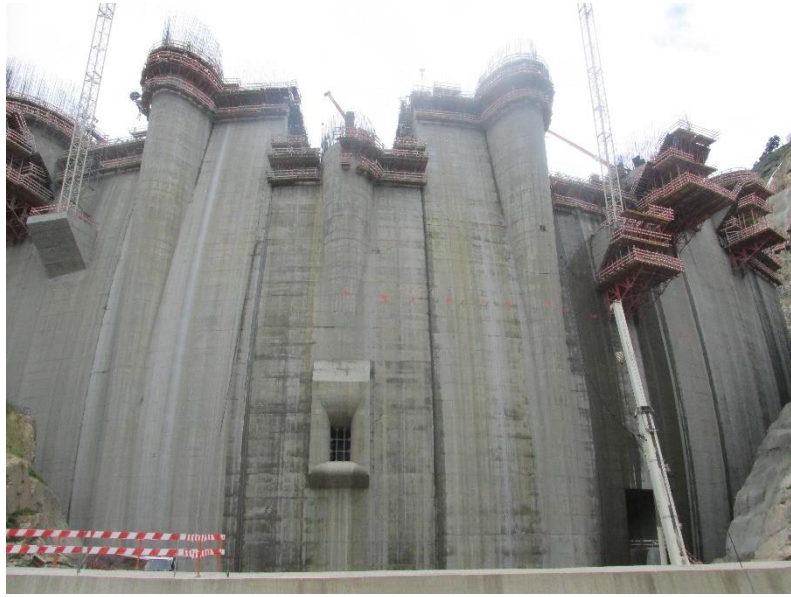
Vista de montante
