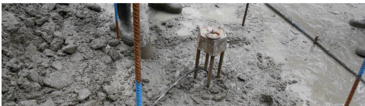
Figura 88 – Betonagem de uma CT num plano horizontal
