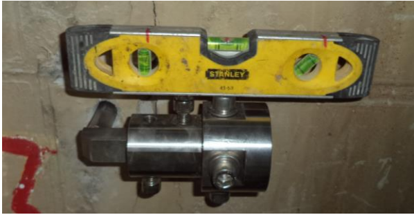
Figura 32 – Instalação de uma BT
