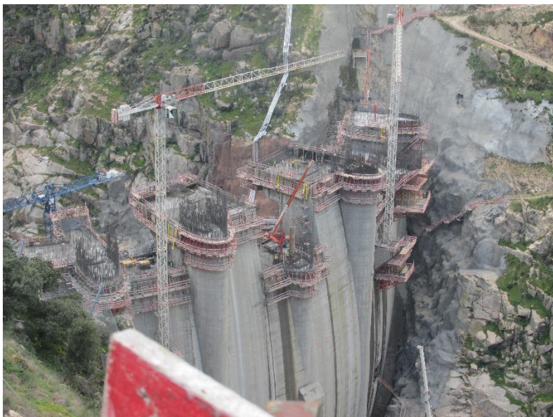
Vista da margem esquerda de montante
