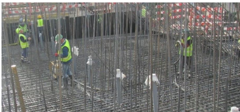
Figura 90 – Vibração do betão com recurso a vibradores manuais
