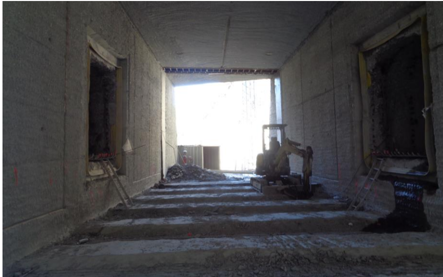
Figura 97 – Trabalhos no orifício provisório
