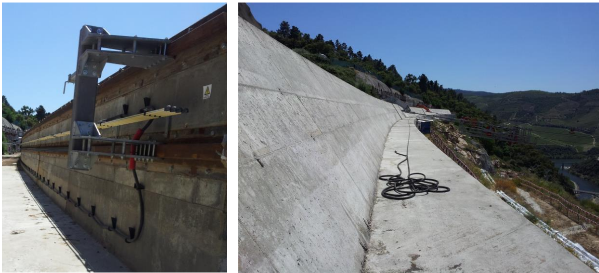
Figura 46 – Viga de betão radial
