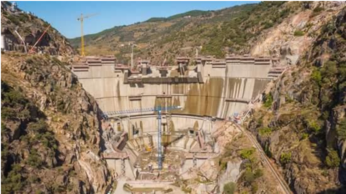
Vista aérea de jusante (SkyEye, 2015)
