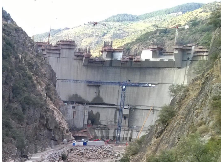
Vista de jusante
