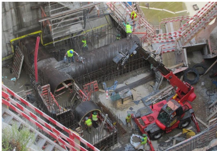
Figura 53 – Colocação da cofragem para GV
