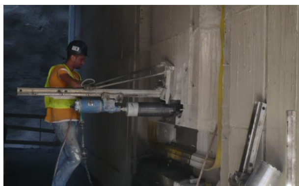
Figura 95 - Execução dos carotes no rolhão
