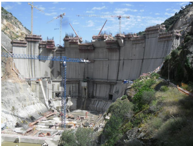
Vista de jusante
