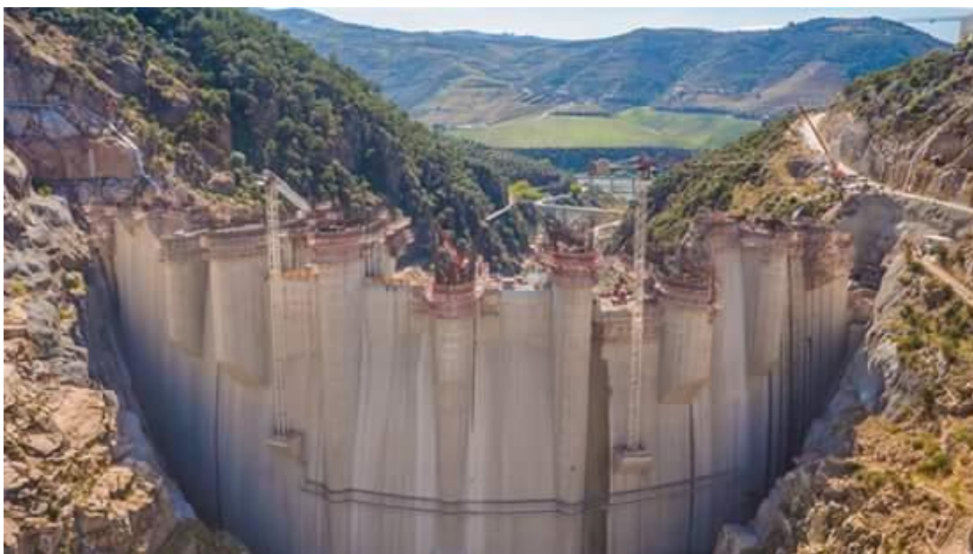
Vista aérea de montante (SkyEye, 2015)
