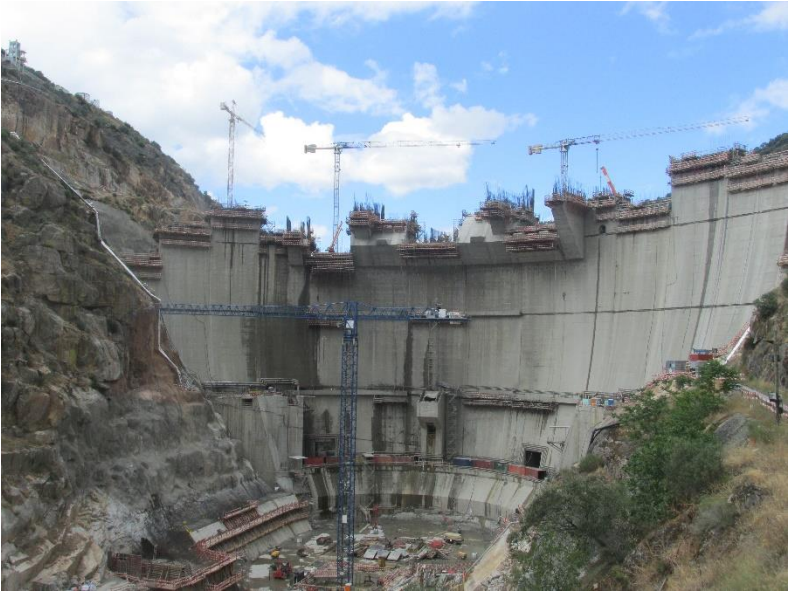
Vista de jusante
