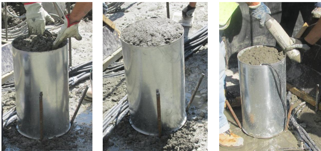
Figura 81 – Enchimento e vibração do balde corretor
