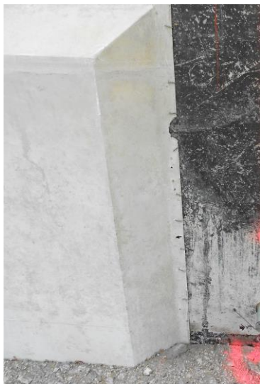
Figura 52 – Cofragem do caixotão
