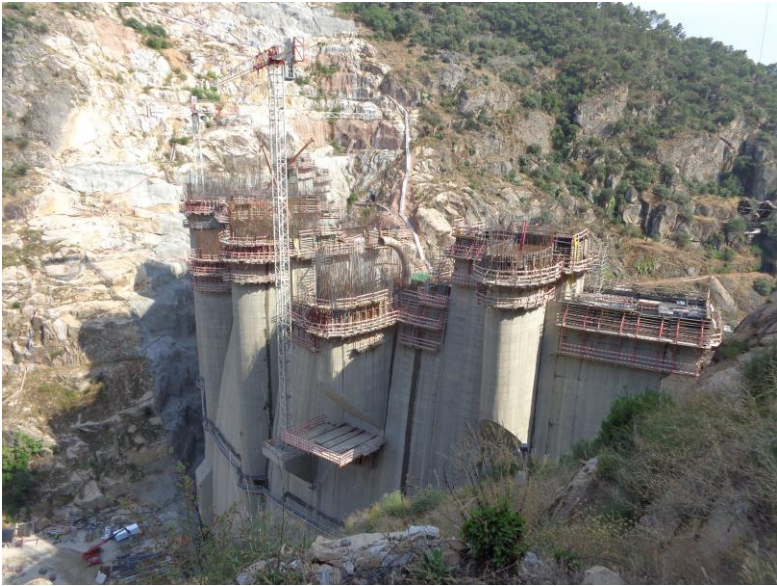
Vista de montante
