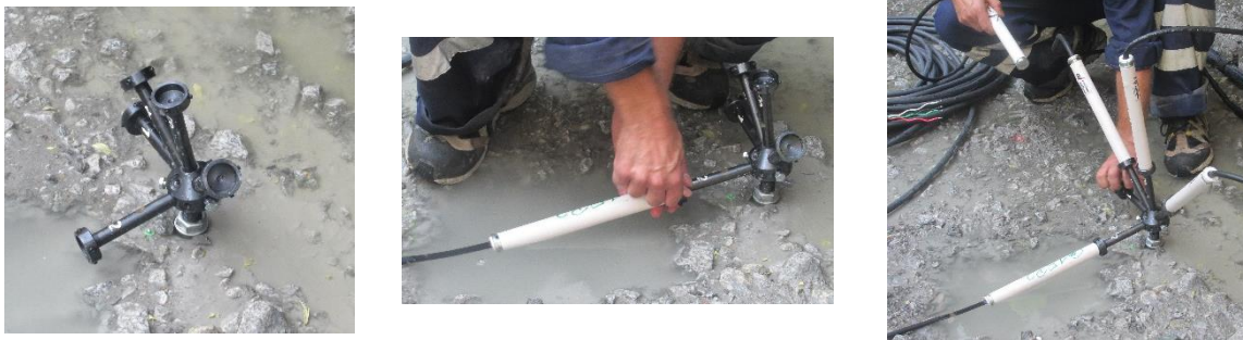
Figura 60 – Instalação da roseta e respetivos extensómetros de resistência de um grupo plano
