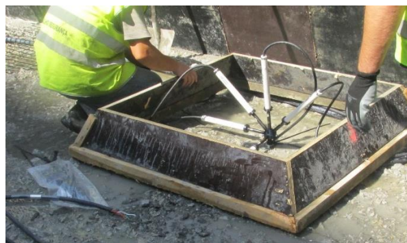
Figura 61 – Colocação do primeiro elemento da cofragem num grupo plano
