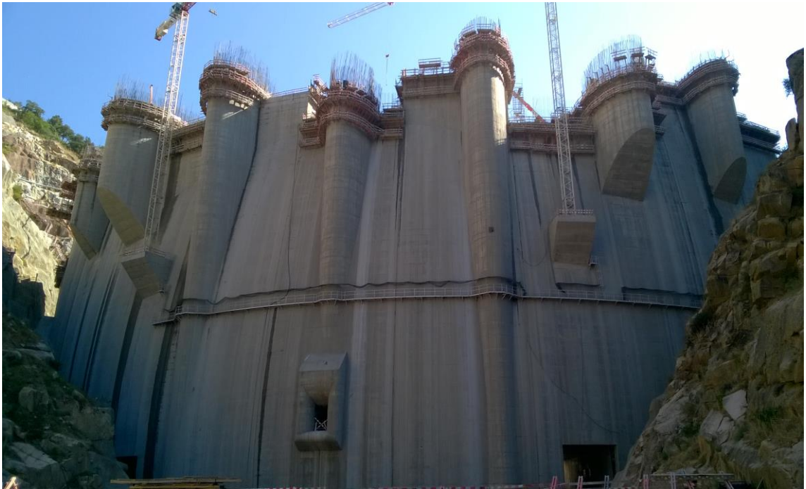
Vista de montante
