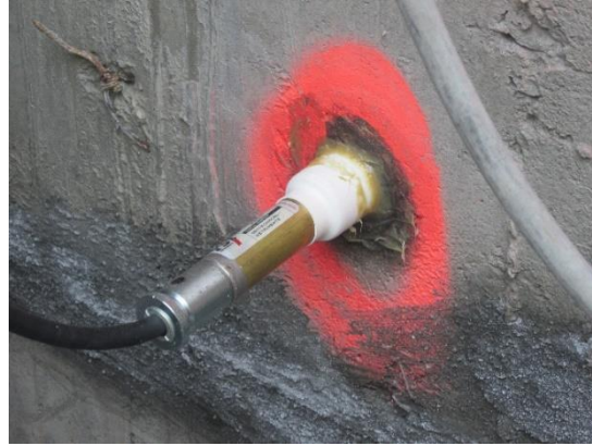
Figura 75 – Colocação de um medidor de movimento de juntas
