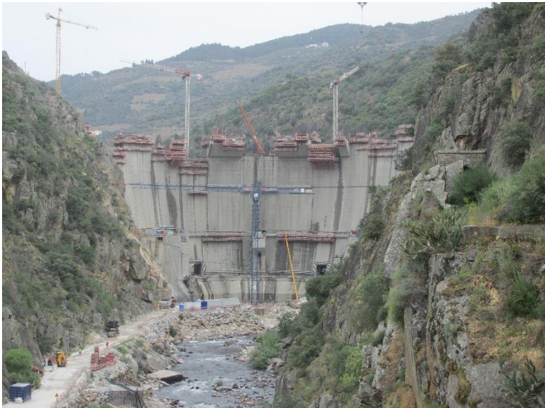
Vista de jusante
