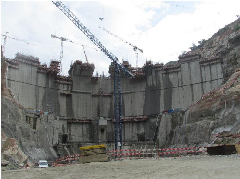
Vista de jusante
