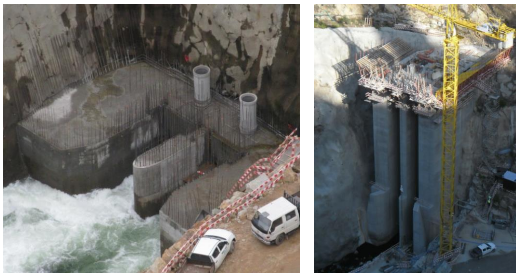
Figura 41 – Evolução da construção da boca de entrada da derivação provisória
