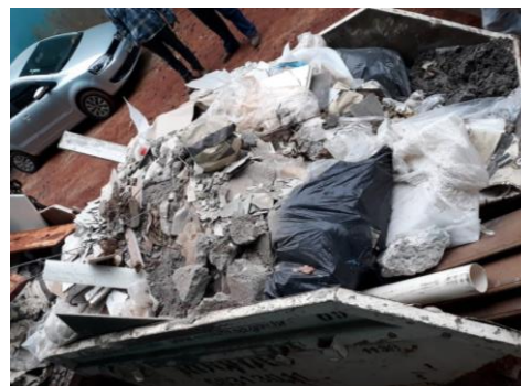
Figura 8.47 - Caçamba com RCD depositados sem algum critério de triagem
