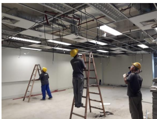
Figura 8.16 – Readequação da rede de Sprinklers
