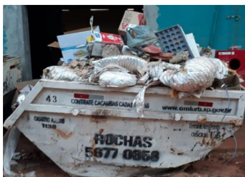
Figura 8.48 - Caçamba com RCD depositados sem algum critério de triagem
