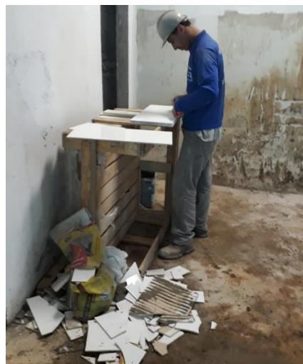
Figura 8.13 - Geração de resíduos de cerâmica devido à falta de planejamento
