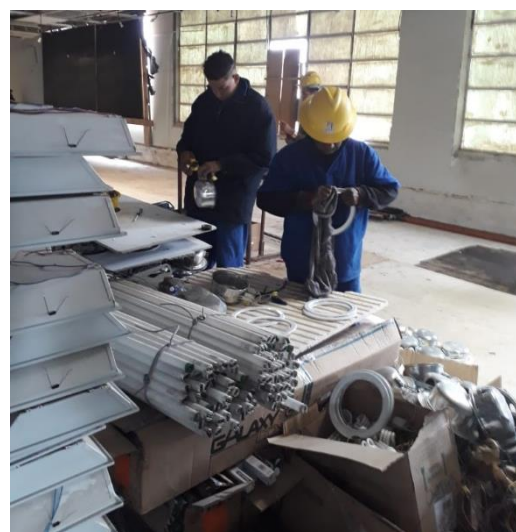
Figura 8.30 – Limpeza e manutenção das luminárias
