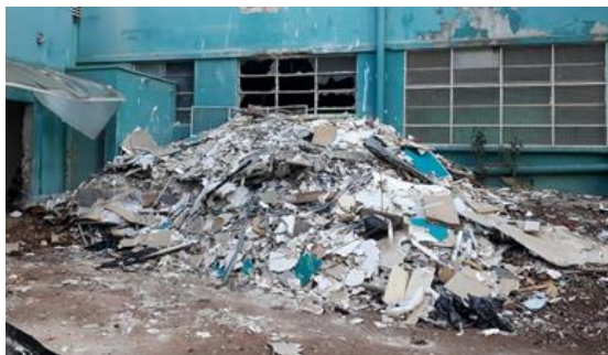
Figura 8.7 – Resíduos gerados pela demolição
