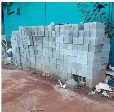
Figura 8.37 – Local A de armazenagem dos blocos
