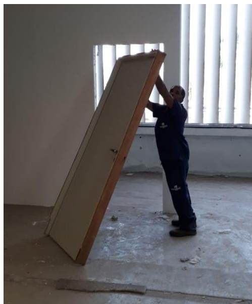
Figura 8.36 – Reutilização interna das portas de madeira
