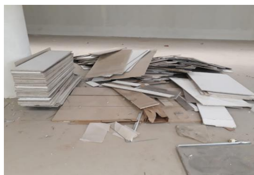
Figura 8.21 – Placas de forro mineral danificadas
