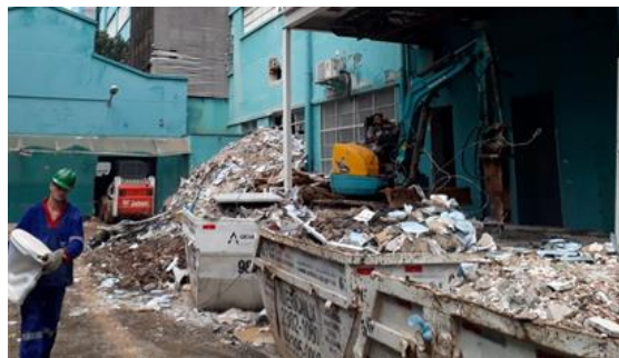
Figura 8.8 - Resíduos gerados pela demolição
