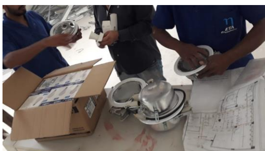
Figura 8.31 – Troca das lâmpadas em luminárias existentes
