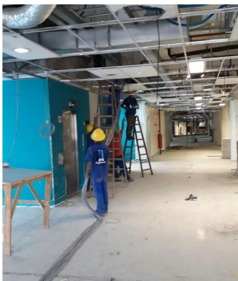
Figura 8.18 – Retirada de instalações obsoletas
