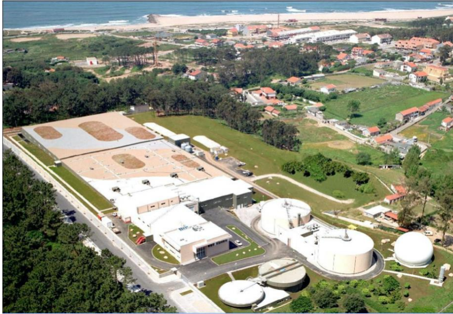
Figura 1.1 Vista aérea da ETAR
