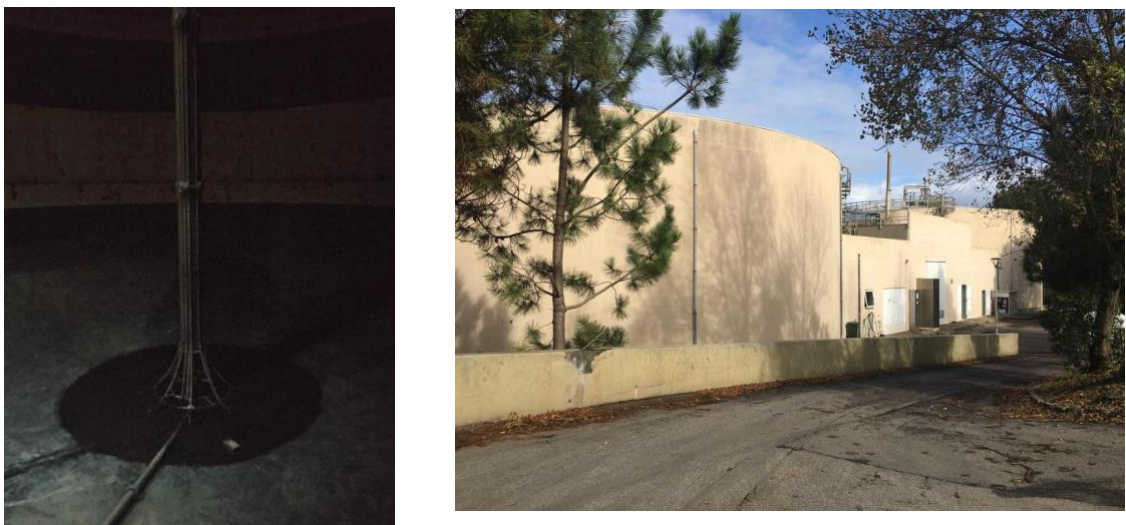
Figura 3.1 Vista do interior e exterior do digestor da ETAR
