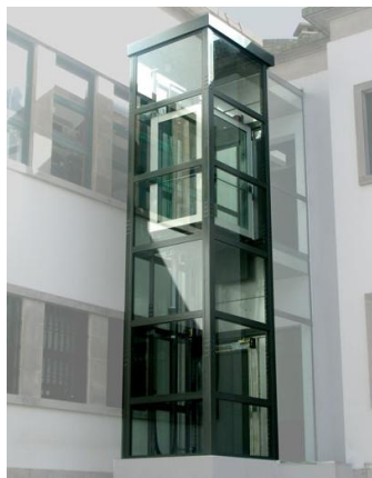
Figura 9 - Estrutura autoportante exterior.
