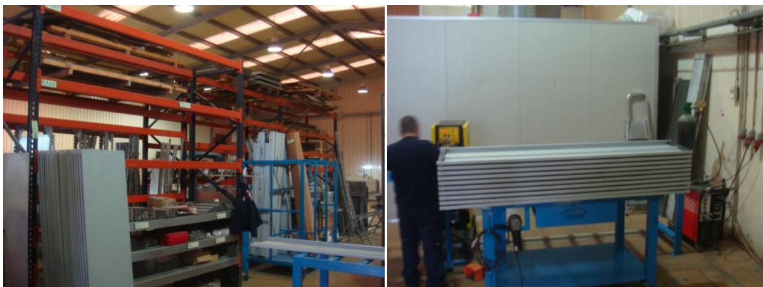
Figura 48 - Zona de armazenamento de materiais e zona de soldadura, ambas antes da intervenção.
