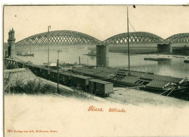
Figura 1.7 – Ponte atirantada sobre o rio Elba
