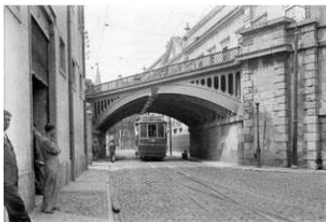
Figura 1.5 – Viaduto de Xabregas [5]
