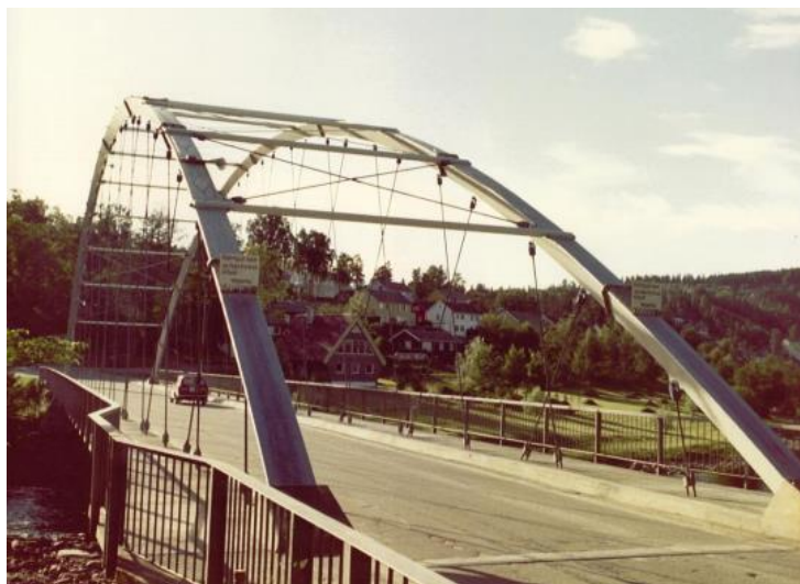
Figura 1.10 – Ponte em Steinkjer [9]
