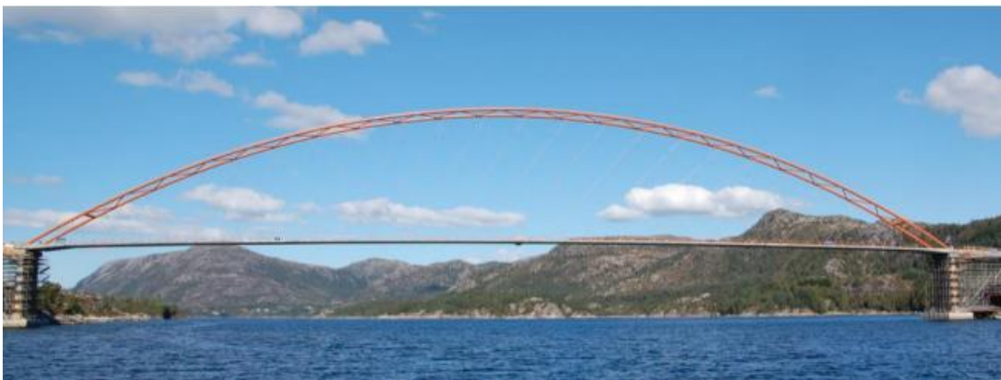
Figura 1.13 – Ponte de Brandanger [7]
