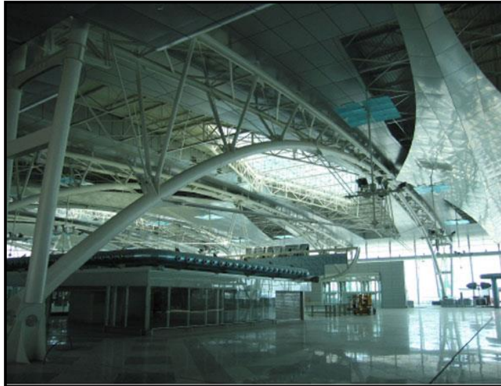
Figura 2.7 – A estrutura metálica do Aeroporto Sá Carneiro é protegida com recurso a tintas intumescentes (SP Project (2007))
