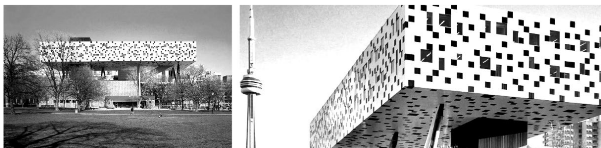
Figura 13. Variação de conteúdo na “janela” do logotipo (cima). Edifício Sharp Centre for Design, cuja fachada serviu de base ao trabalho de Bruce Mau (baixo). Fonte: “ www.brucemaudesign.com/work/ocadu ”
