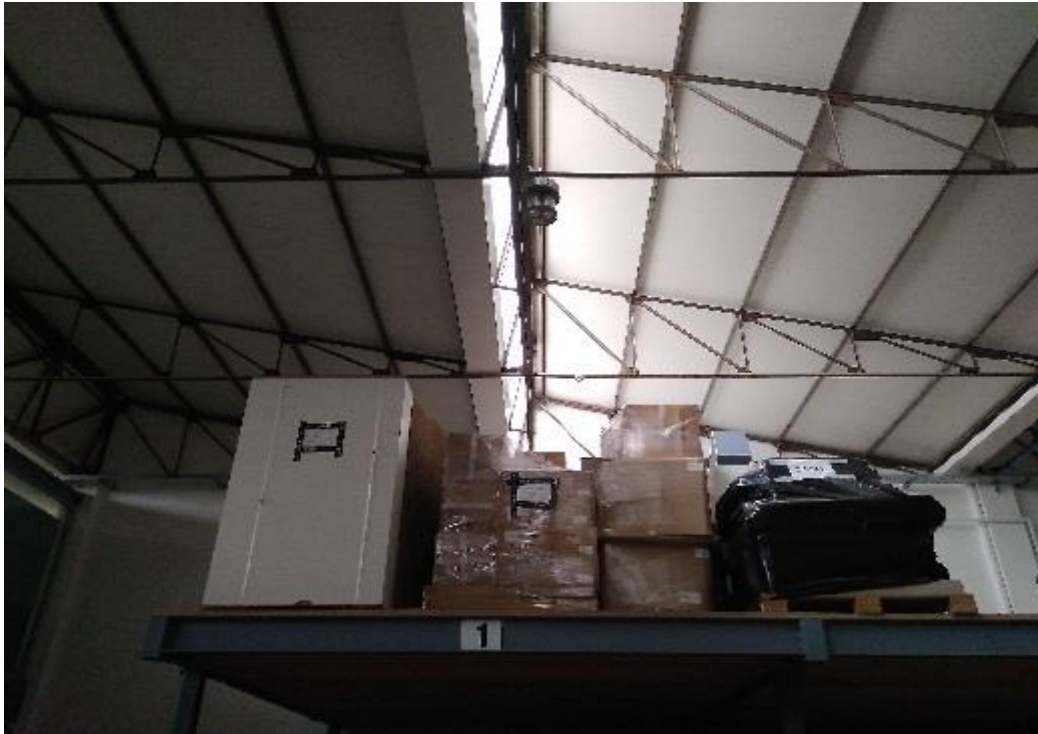
Figura 30: Zona para armazenagem de material obsoleto
