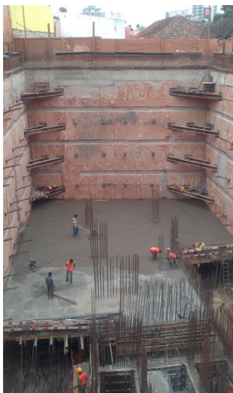
Figura 4.3 - Imagem do projecto de execução, na fase de construção, do Edifício Vandunen.
