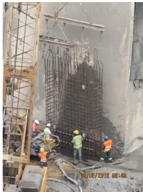
b) Armadura da parede moldada.
