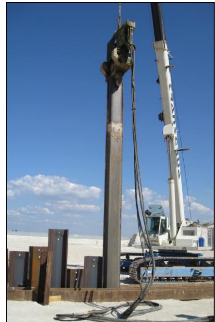
b) Cravação de perfis utilizados em cortinas estacas-prancha.
