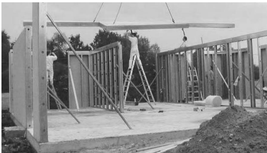
Figura 1 - Estrutura em aço e placa de madeira compensada (contraplacado) [43].
