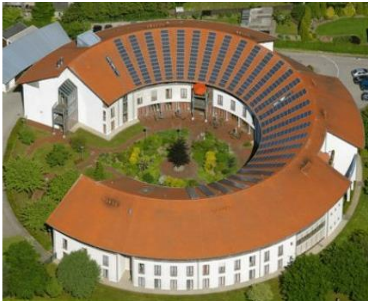
Figura 16 – Instalação de PV
