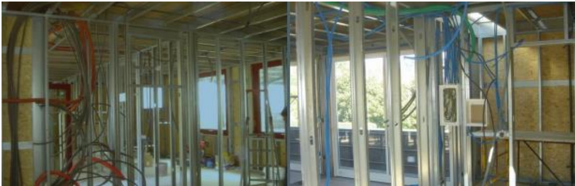
Figura 54 – Furações estruturas metálicas
