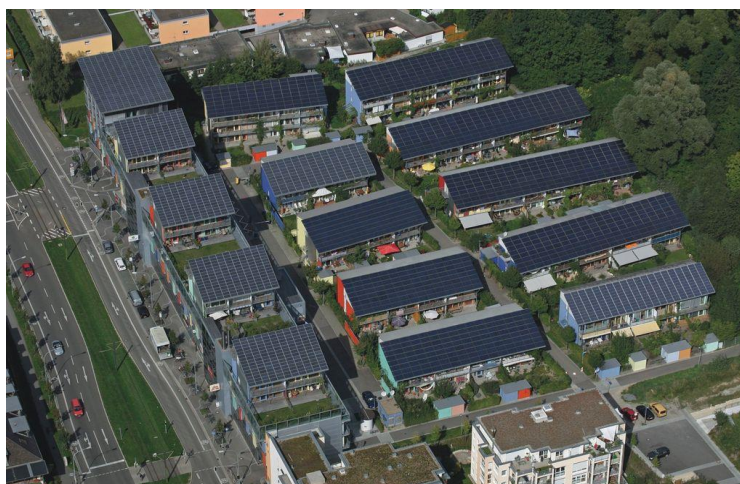
Figura 17 - Telhados solares da Grã-Bretanha
