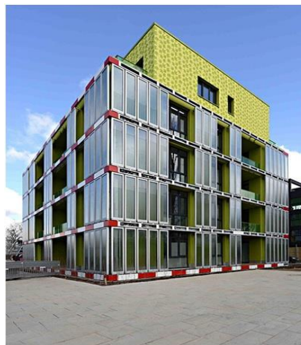
Figura 24 - Fachada ecológica de um edifício na Alemanha
