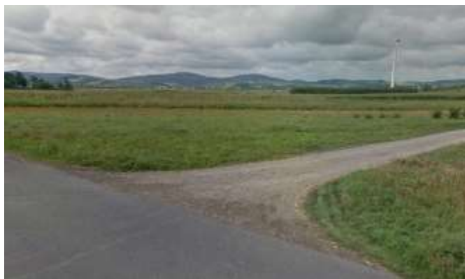
Figura 16 – Melhoramento dos acessos
