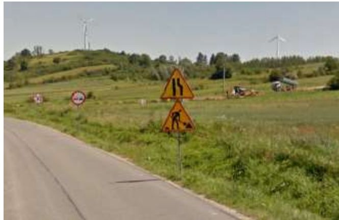
Figura 14 – Sinalização da obra
