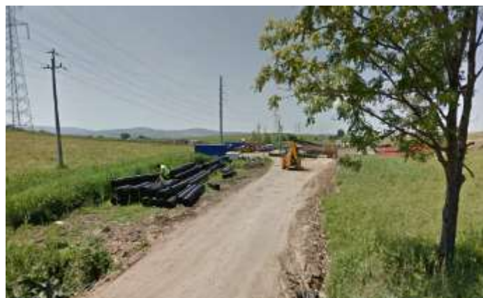
Figura 13 – Montagem do estaleiro
