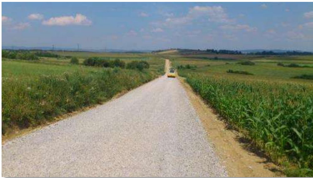
Figura 42 – Compactação do pavimento
