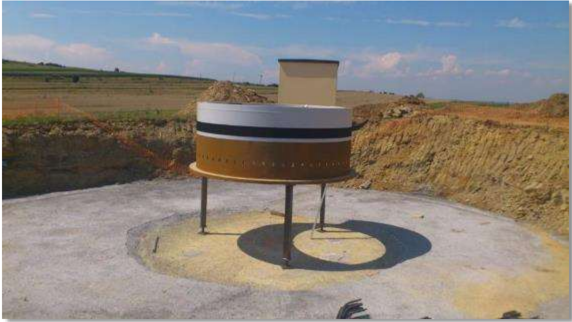
Figura 55 - Colocação do anel de fundação
