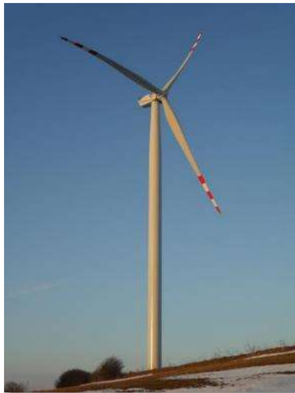
Figura 78 – Aerogerador após a montagem
