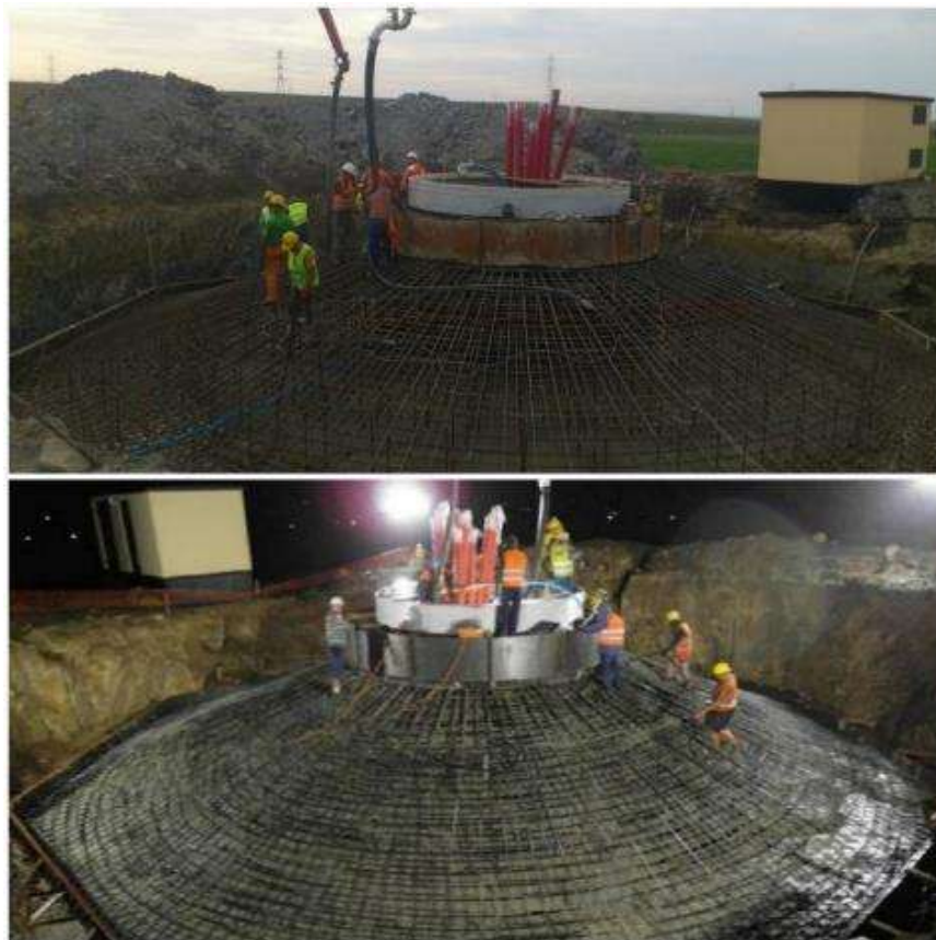
Figura 59 – Início da betonagem (em cima) e betonagem à noite com o uso de lâmpadas de halogéneo (em baixo)
