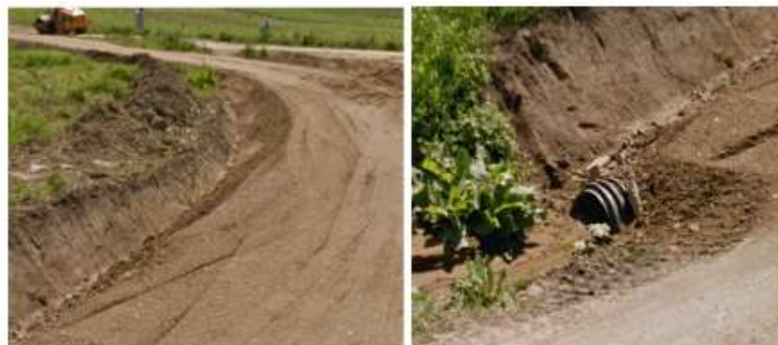
Figura 15 – Valeta e passagem hidráulica
