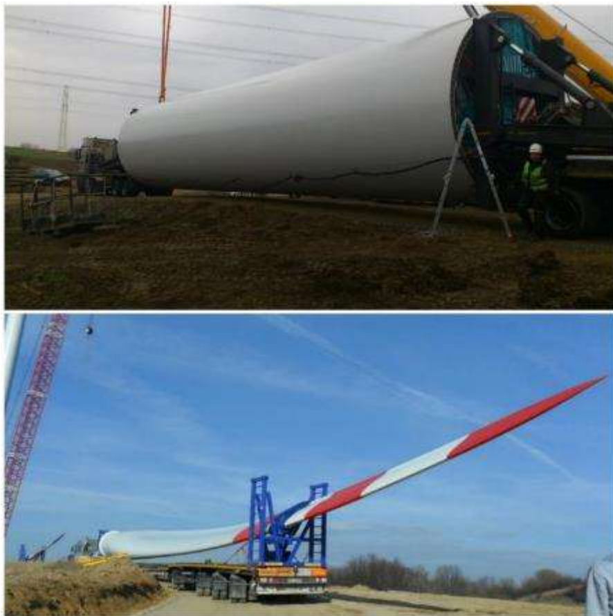
Figura 66 - Preparação para descarregar a secção da torre (em cima) e as pás (em baixo) no local
