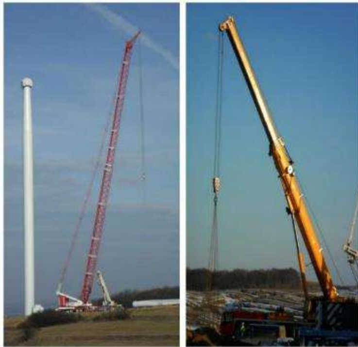
Figura 70 - Grua principal (do lado esquerdo) e grua auxiliar (do lado direito)
