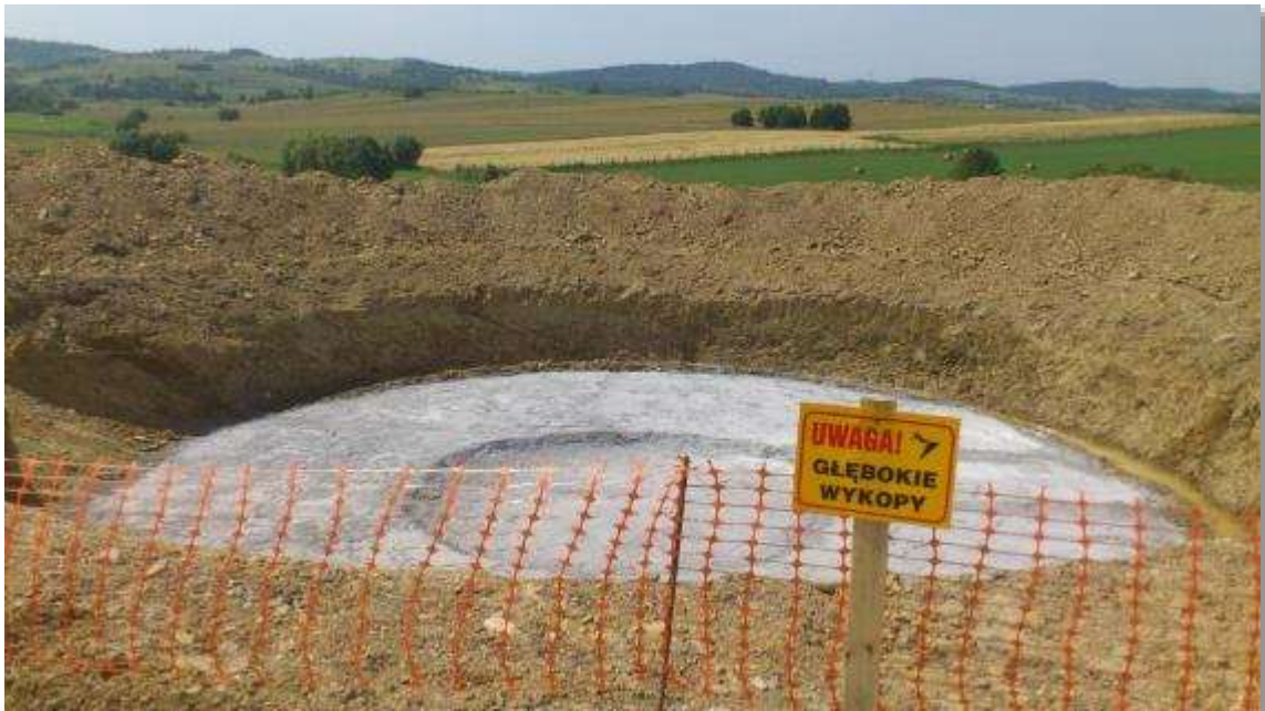
Figura 54 – Colocação da camada de betão de limpeza
