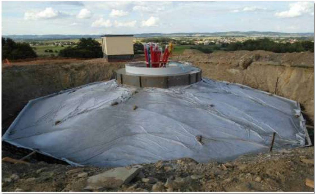
Figura 61 - Cura do betão
