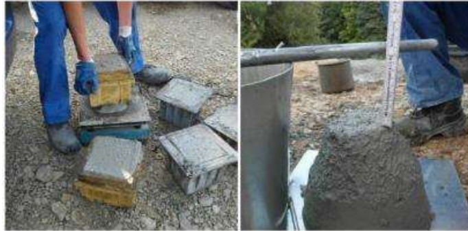
Figura 58 – Provetes para verificação da consistência do betão
