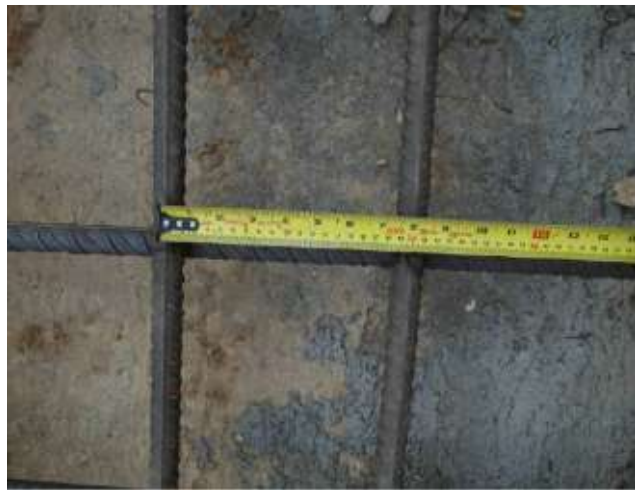
Figura 56 - Malha de armadura
