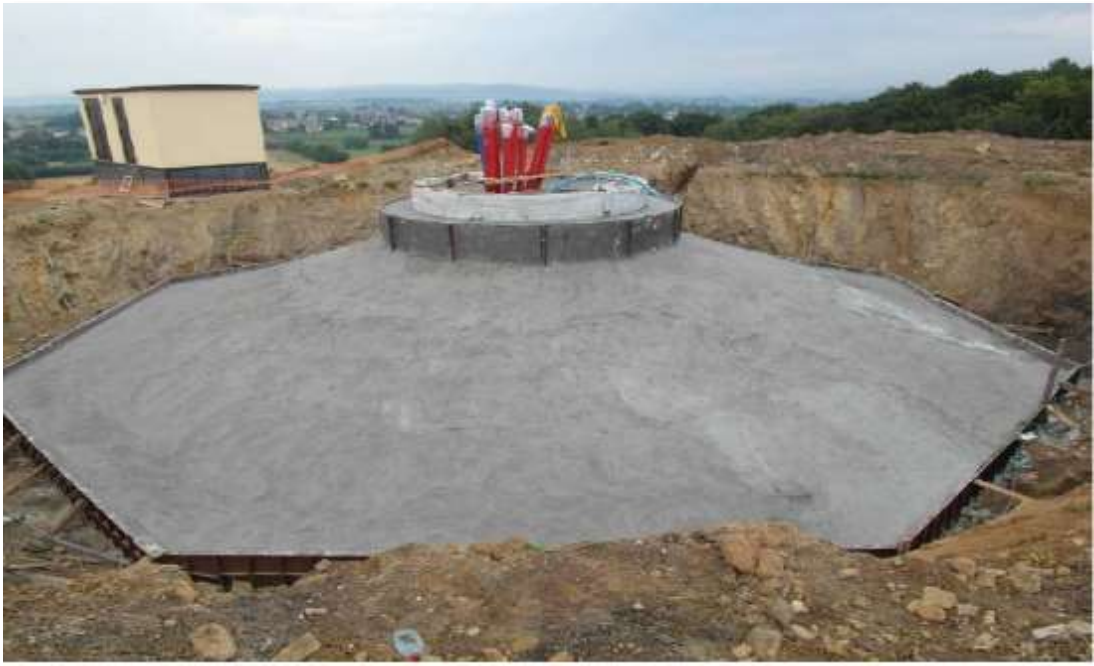
Figura 60 - Após a betonagem
