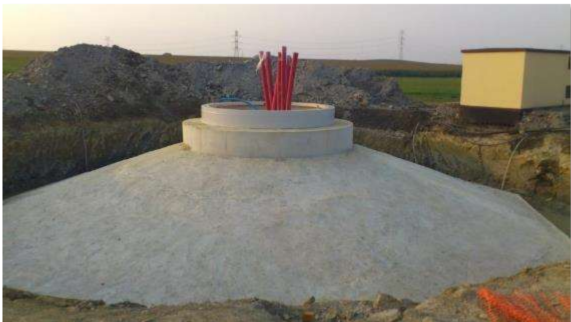
Figura 62 - Fundação após remoção da cofragem
