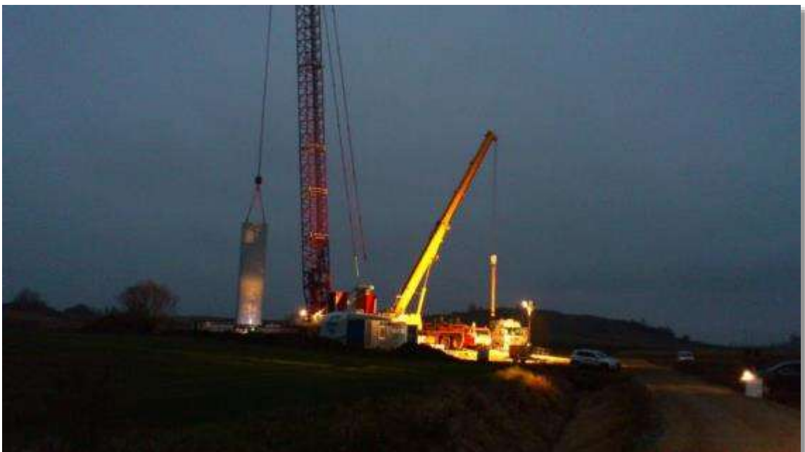
Figura 72 – Montagem da torre
