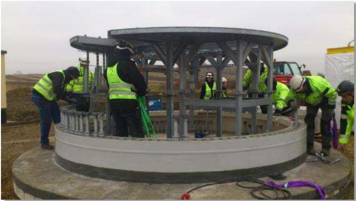
Figura 71 – Preparação da base da torre
