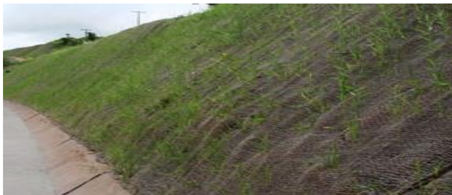
Figura 3.12 - Revegetação de talude sob geotêxtil (Fonte: sgborracha.com.br)
