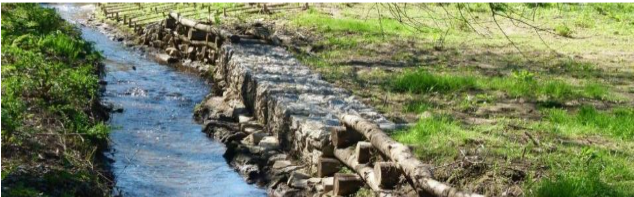
Figura 3.6 - Muro gabião Fiães, Santa Maria da Feira (cedida por Teiga, P.)
