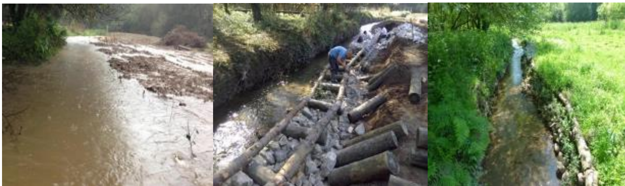
Figura 5.7 - Laboratório de rios antes, durante e depois da sua construção (cedida por Teiga, Pedro)
