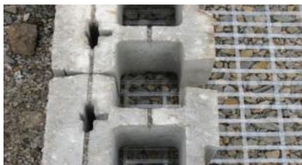
Figura 3.1 - Aplicação de blocos pré-fabricados sob camada de material drenante. (Fonte: eagm.eu)
