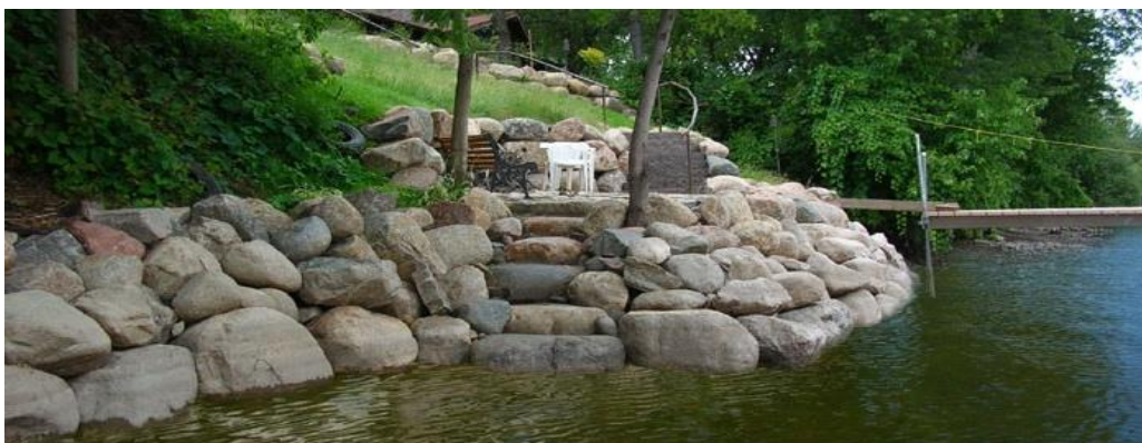
Figura 3.5 - RipRap para controlo de erosão no Minnesota, Estados Unidos da América (Fonte: naturalenviromentscorp.com )
